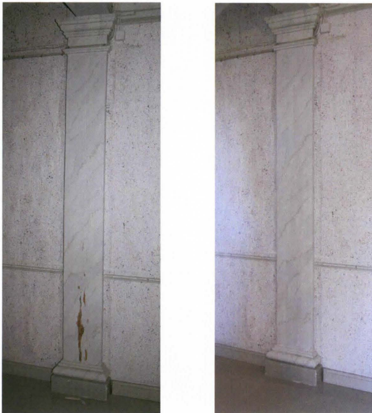
Kuva 34. Ennen ja jälkeen (kuva 35) kuvat pilasterista F.
