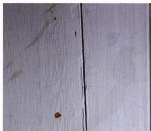
Kuva 63. Pilari I sivu II värinkiinnityksen jälkeen. (Vilja Hedengren)
