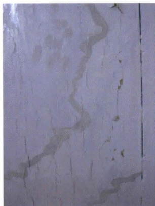
Kuva 28. Ennen ja jälkeen ( kuva 29) kuva A pilarin sivulta II.
