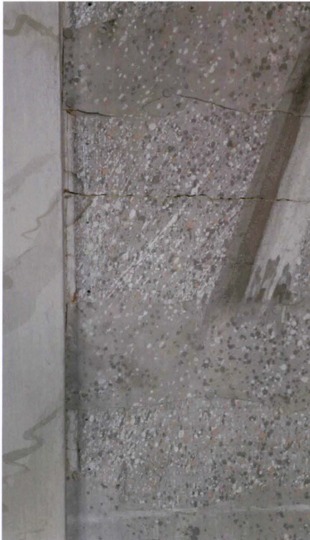
Kuva 69. Kuvan 15 haalistuneet paikkapalat retusoinnin jälkeen. Kohta on eteläseinältä ovien vasemmalta puolelta. (Anette Viitaniemi)
