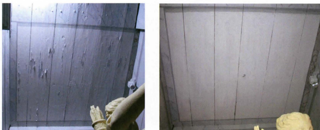
Kuva 40. Ennen ja jälkeen (kuva 41) kuvat pilareiden rajaamasta keskikatosta. Kuvan oikeassa alakulmassa on piiloon paperoitu vanhempi liimamaali.
