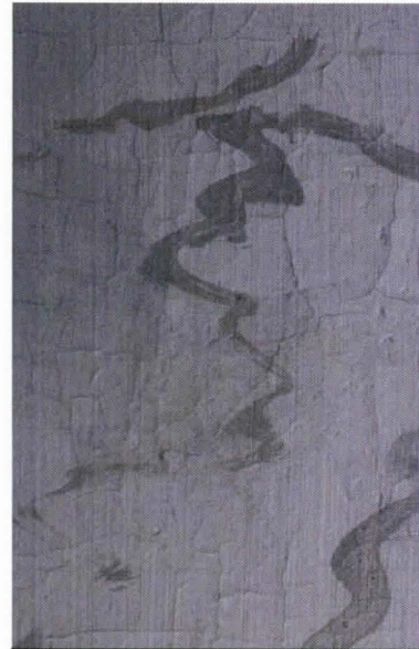
Kuva 65. Pilarin I sivu IV värinkiinnityksen jälkeen. (Mikko Iivonen)
