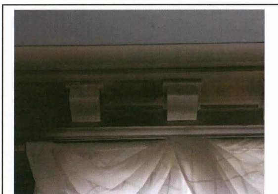
Kuva 82. Konsolit kiinnitetty ja paikkamaalattu. Kuvaaja: H. Kuvaja
