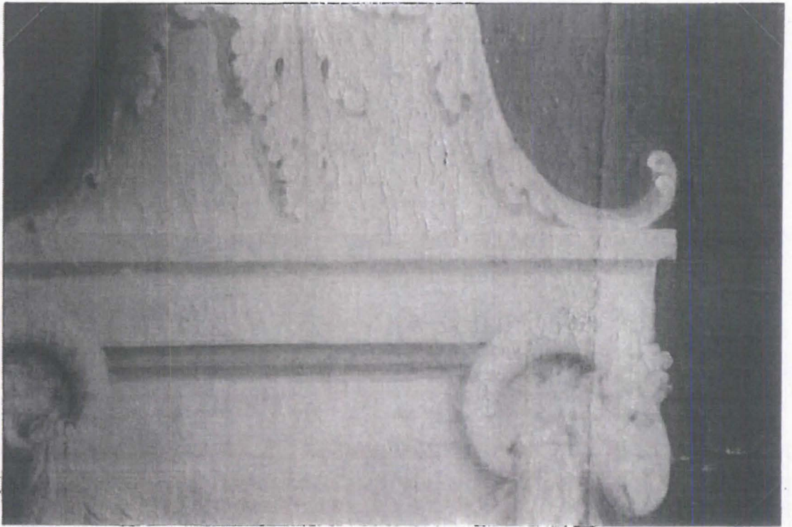
Kuva 21. Itäseinä. Vaalea värialue ennen konservointia.
