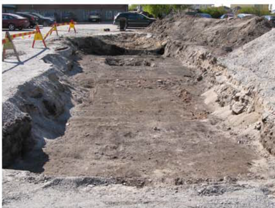
Kuva 9. Alue C, aloitustaso ennen paalutusta. MV/RHO.
