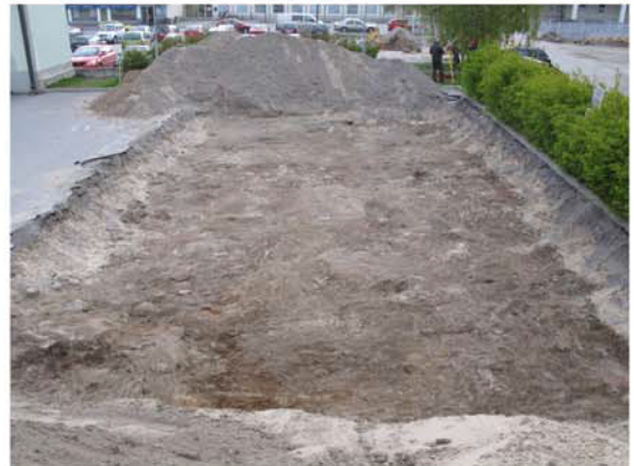
Kuva 6. Alue F, aloitustaso ennen paalutusta. MV/RHO.
