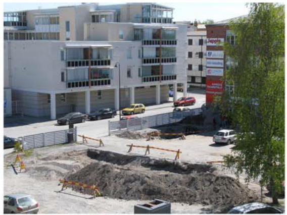
Kuva 39. Kaivausalueet C ja D, yleiskuva. MV/RHO.
