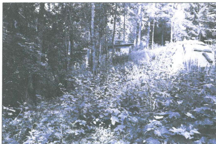
125766:54 Joentaka 4, rakennuspaikka 13. Yleiskuva rakenteesta 2. Itä-kaakosta. 10.8.2007.
