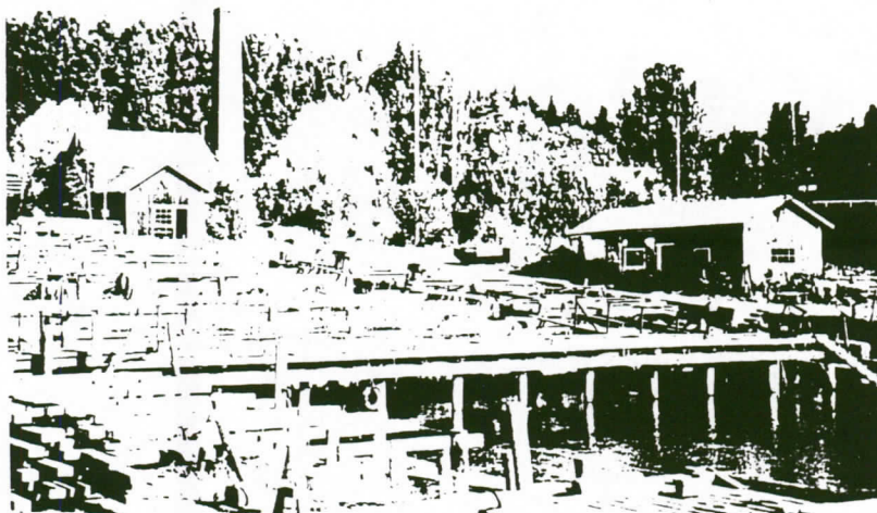
Kuva 4. Vinssihuone (4). Etuoikealla työkaluvarasto (2). Vinssihuoneen takana näkyy vanha voima-asema (5) savupiippuneen.
