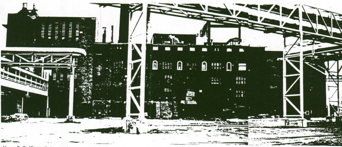
Kuva 2. Sulfiittiselluloosatehtaan vuonna 1930 valmistunut keittamo (1a). Sen vasemmalla puolella 1950-luvun lopussa rakennettu valkaisuosasto (1c) ja oikealla, hieman viistosti takana 1960-luvun alussa pystytetty pesuosasto (1d).
