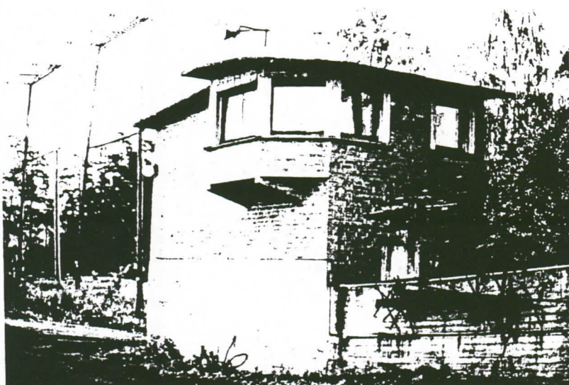
Kuva 7. Hiilikentalta voimalaitokseen hiilta kuljettaneen laahakoneen ajokoppi konahuoneineen (7).
