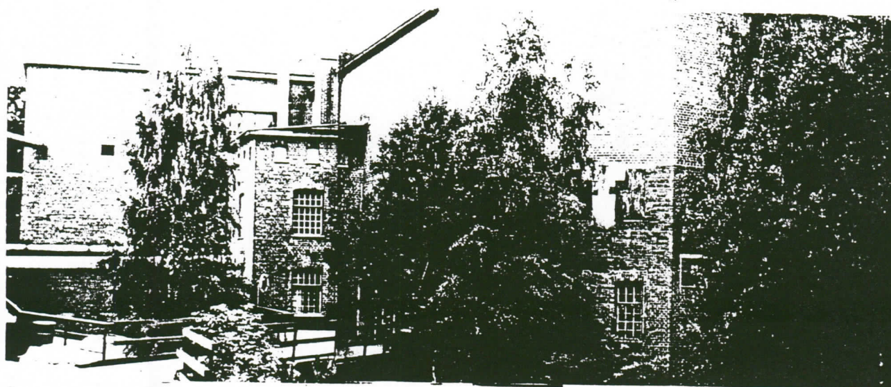
Kuva 2. Vanhan holanterirakennuksen (1) eteläjulkisivua myöhemmin pystytettyine porrashuoneineen. Oikealla näkyvät lumppulinnasta (17) pesuholanteriosastoon tulleen kuljettimen aukot. Taustalla näkyy vanhan valkaisuosaston (8) itäosaa. Holanterirakennusta on korotettu 1940-luvun lopussa valkaisuosaston rakentamisen kanssa.
