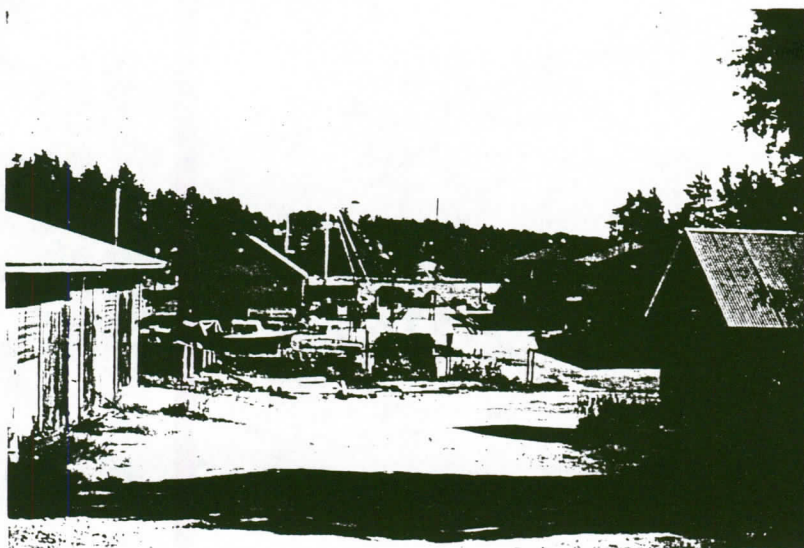
Kuva 1. Yleiskuva Laitaatsillan telakka-alueesta. Etualalla vasemmalla uuden paloasema-autotallirakennuksen pääty. Sen kanssa samassa linjassa alempana Gutzeitin tahti-ikkunoin koristetun tavaravaraston (8) pohjoispaaty. Tavaravarastosta oikealla sijaitsee koneistamo- ja toimistorakennus (11). Siitä katsojaan pain näkyvä rakennus on levy- ja moottorinkorjauspaja (6). Etummaisena oikealla on veneistamo- ja puusepanrakennuksen (11) itäpaaty.
