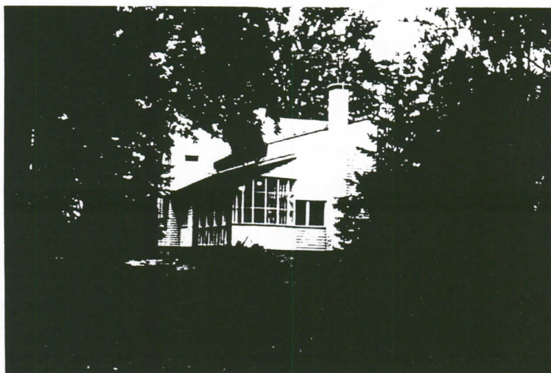
Kuva 3. Insuliittitehtaan johtajan asuinrakennus etelästä
