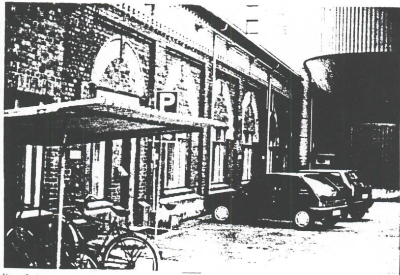
Kuva 5. Automaatiokorjaamon (1f) länsijulkisivua, joka on peräisin vuonna 1907 käynnistyneestä sulfaattiselluloosatehtaasta.
