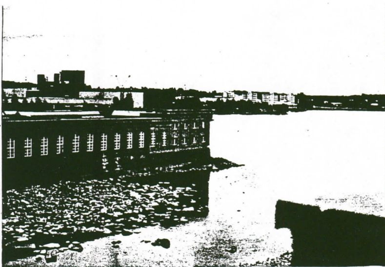
Kuva 1. Kartonkitehdas (1a). Tehtaan oikeanpuoleisin osa on arkkitehti Alvar Aallon 1940-luvun lopussa suunnittelema laboratoriosiipi.
