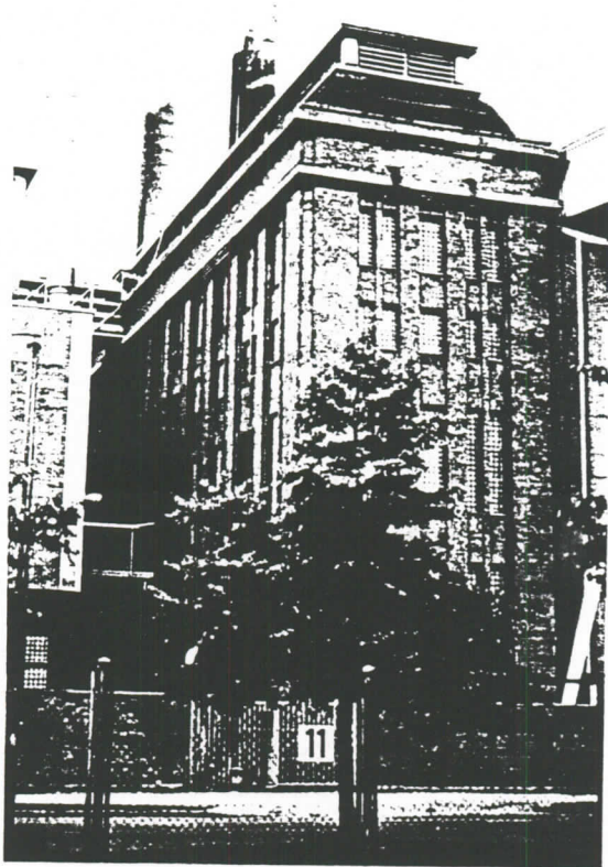
Kuva 2. Thomen veljesten suunnittelema keittamo (6a) Sen Ahlstrominkadun puoleinen, vanhan keittamon keittamon kanssa samantyyllisenä rakennettu paaty on 1950-luvun lopulta
