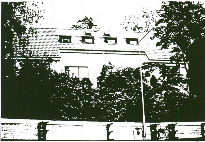
Kuva 13. Rantalinja (32). Kuvan alareunassa näkyy paperitehtaalta kartonkitehtaalle kulkeneen höyryputken telinettä.
