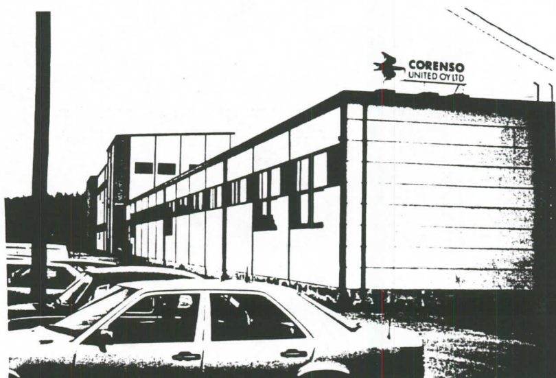
Kuva 3. Hylsytehtaan 1980-luvulla tehtyä laajennusta
