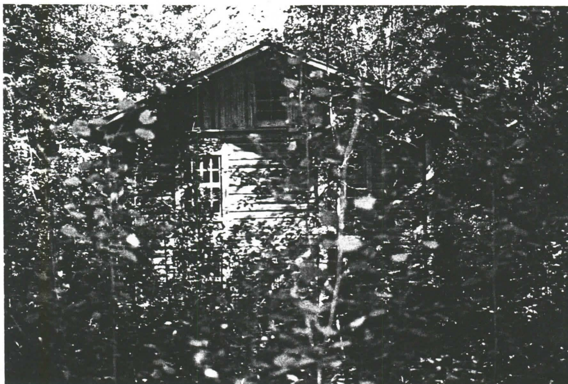
Kuva 2. Padon puoleinen pääty, jossa on myllyn sisäänkäynti.
