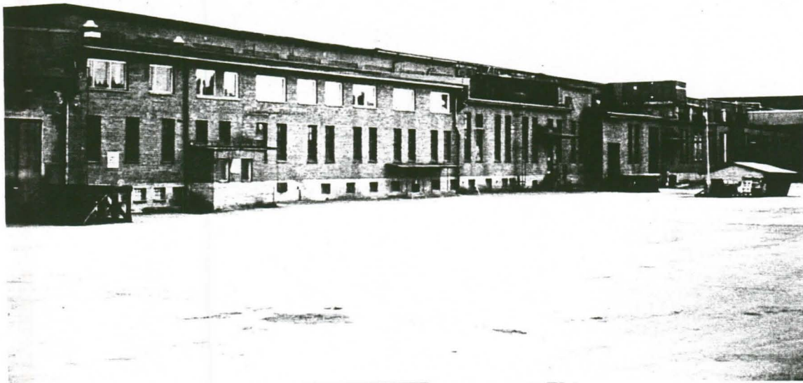
Kuva 2. Insuliittitehtaan läntisen sivulaivan pohjoispäätä. 1960-luvulla pystytetty toimistolaajennus erottuu vanhemmasta, 1940-luvulla rakennetusta sivulaivasta aavistuksen tummempana. Kostutusuunisali sijaitsee siitä oikealla. Ylempi kerros on rakennettu 1960-luvulla.
