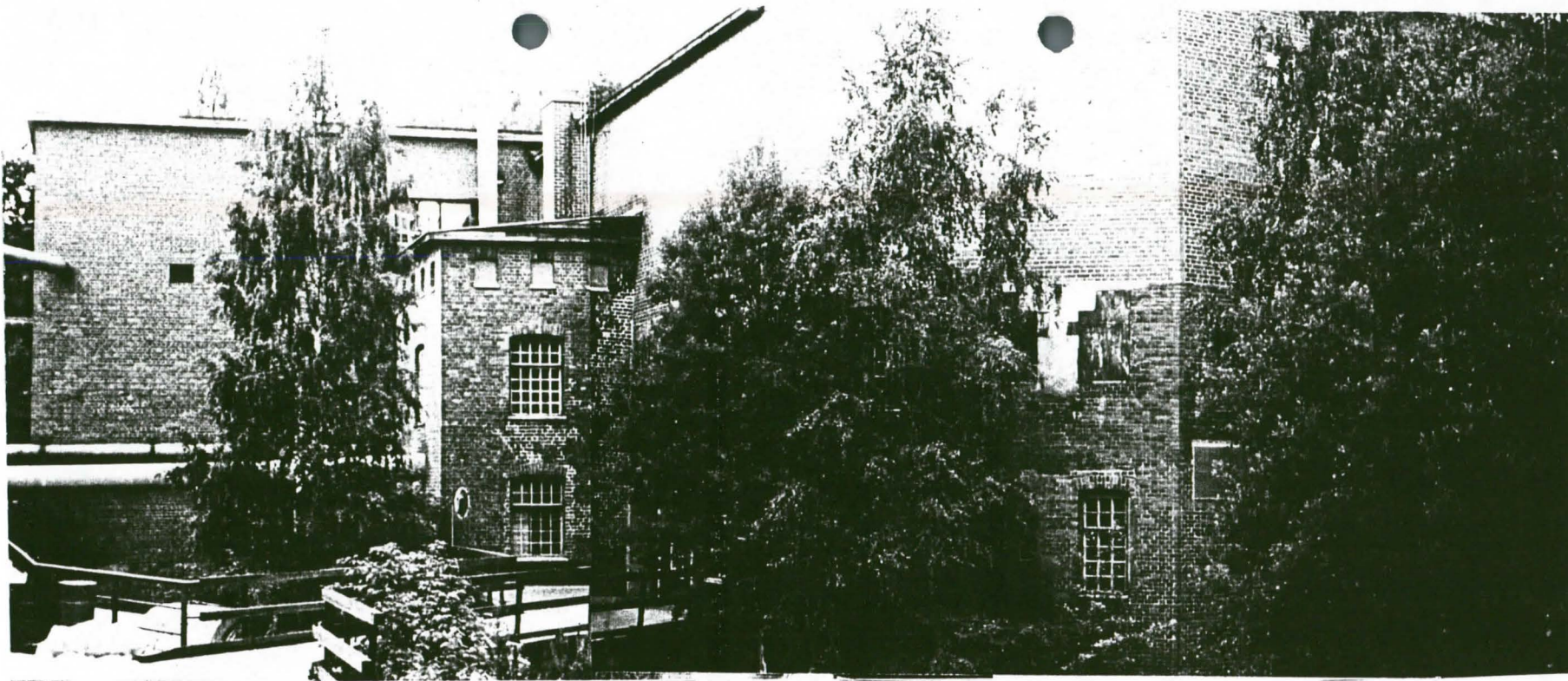
Kuva 2. Vanhan holanterirakennuksen eteläjulkisivua myöhemmin pystytettyinen porrashuoneineen. Oikealla näkyvät lumppulinnasta pesuholanteriosastoon tulleen kuljettimen aukot. Taustalla näkyy vanhan valkaisuosaston itäosaa. Holanterirakennusta on korotettu 1940-luvun lopussa valkaisuosaston rakentamisen kanssa.
