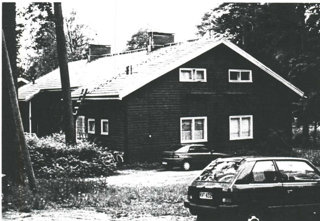
Kuva 20. Keltalinjan asuinrakennus. Pohjoisesta.
