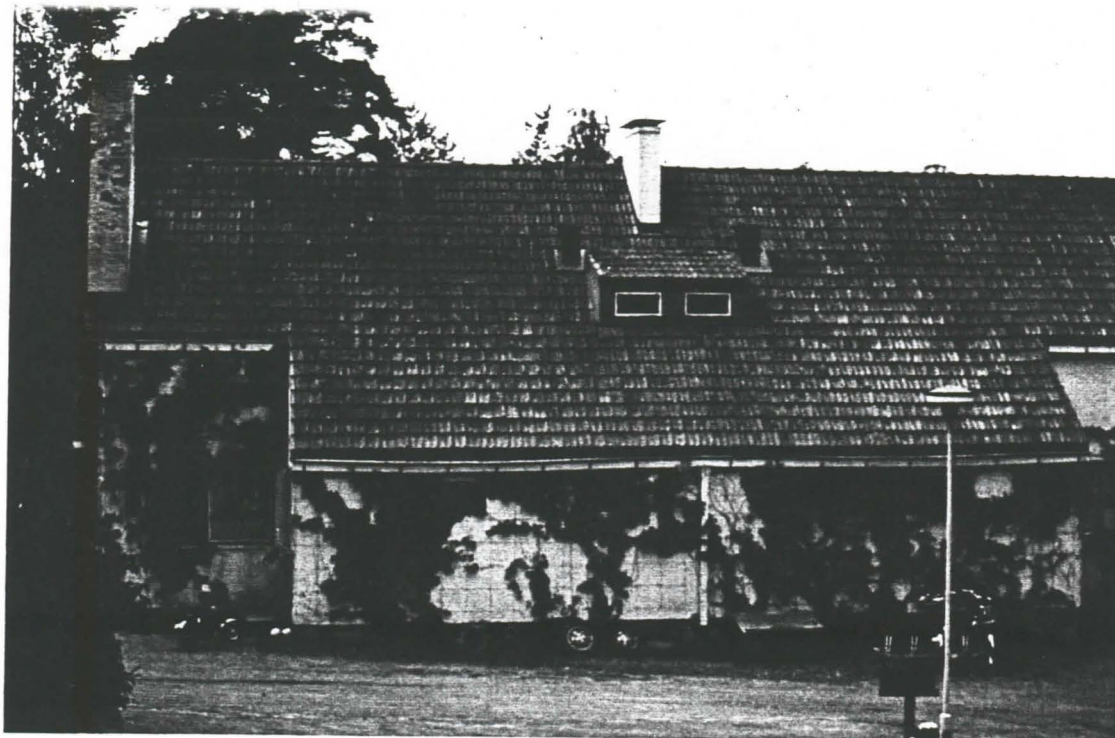
Kuva 23. Rantalinjan asuinrakennus. Idästä.
