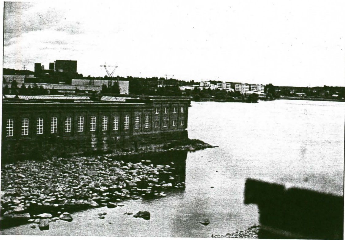
Kuva 1. Kartonkitehdas lännestä. Tehtaan oikeanpuoleisin osa on A. Aallon 1940-luvun lopussa suunnittema
