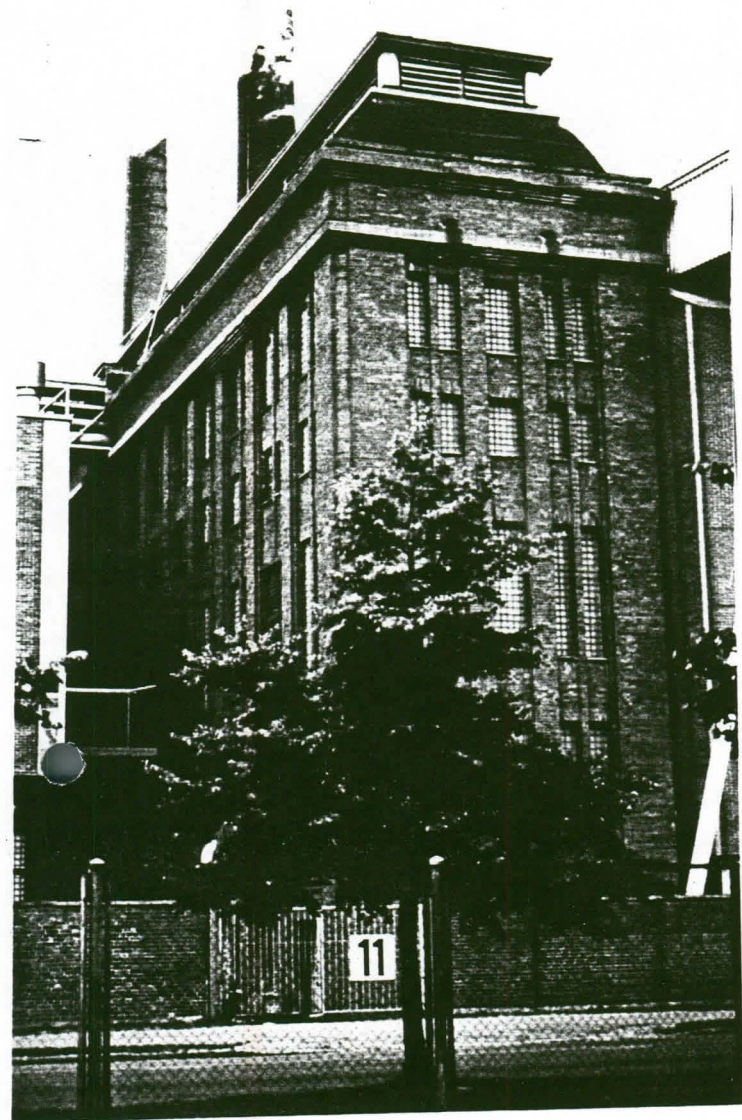
Kuva 7. Thomén veljesten suunnittelema keittämö. Sen Ahlströminkadun puoleinen, vanhan keittämön keittämön kanssa samantyyllisenä rakennettu pääty on 1950-luvun lopulta.
