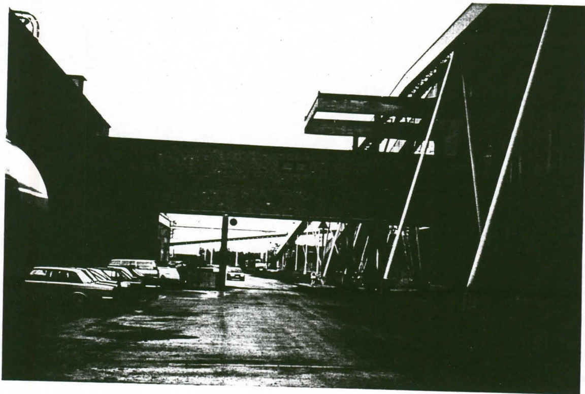
Kuva 1. Summan sanomalehtipaperitehtaan hiomon ja voimalaitoksen välinen alue. Vasemmalla hiomo ja oikealla voimalaitos, jonka editse kulkee Hillosta tuleva raide. Raide johtaa kuorimolle. Voimalaitoksen ja hiomon yhdistää ylikulkukäytävä.
