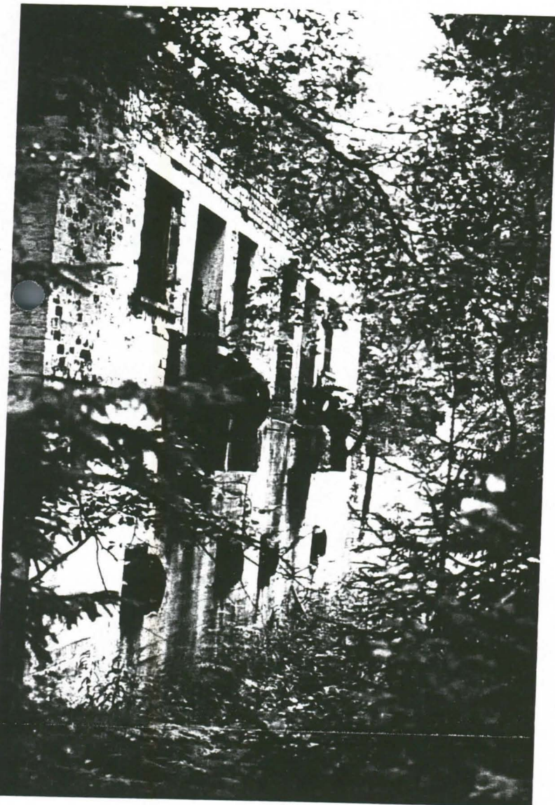
Kuva 2. Myllylamesta ylösnostetut tukit ohjattiin hammasrattaiden vieressä olevista aukoista kaksiosaiseen uittokouruun, josta ne uitettiin, Kärjenlampeen. Kärjenlampi sijaitsee virtaukseltaan Myllylampea ylempänä, minkä vuoksi uittokouruihin jouduttiin pumpaamaan vettä vesipumpuilla. Kahdesta vesipumpusta tulevat neljä vesiputkea näkyvät rakennuksen alaosassa. Yhtä uittokourua varten oli kaksi putkea.
