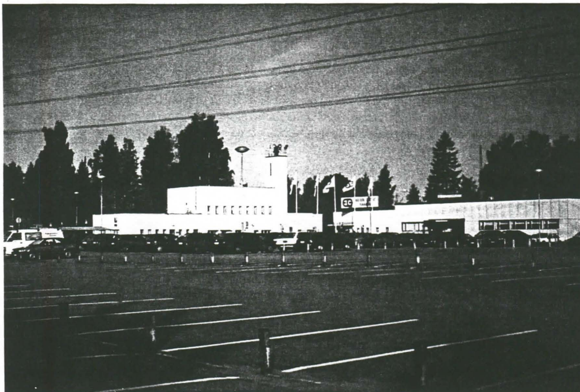
Kuva 4. Kaukopään tehtaan paloasema. Sen oikealla puolella porttirakennus laajennuksineen.
