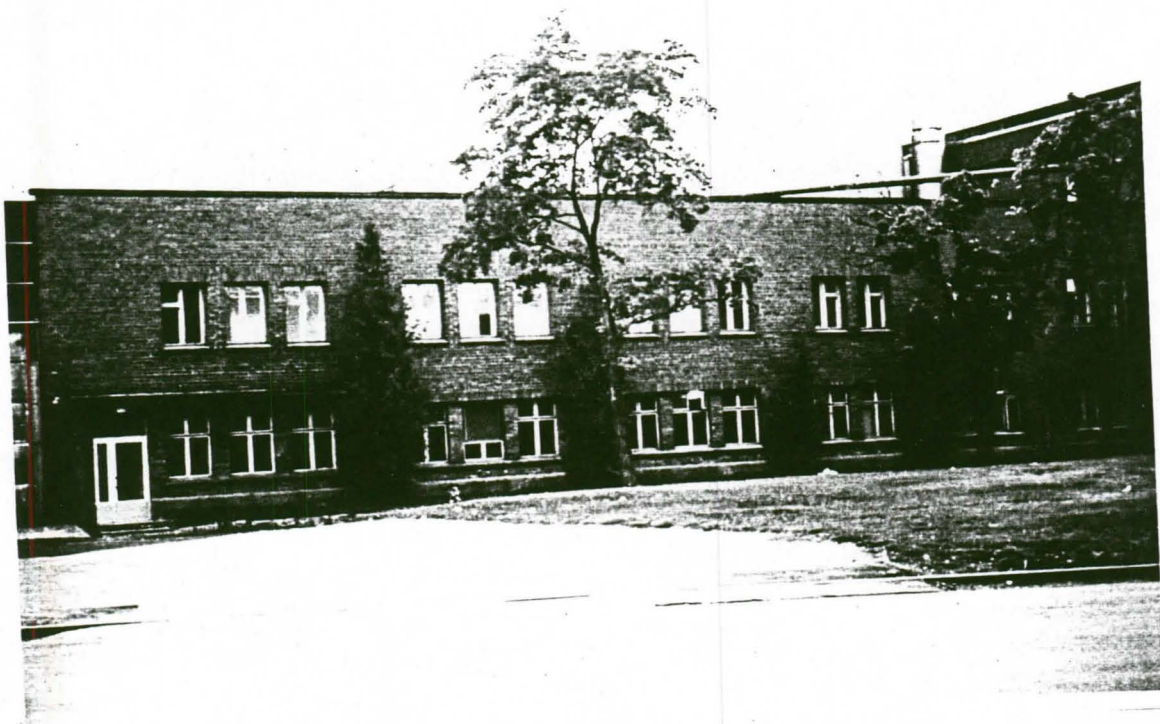
Kuva 8. Arkkitehti Gunnar Aspelinin suunnitelmien mukaan laajennettua ja korotettua vaneritehtaan toimistosiipeä, jonka takana sijaitsee liimausosasto.
