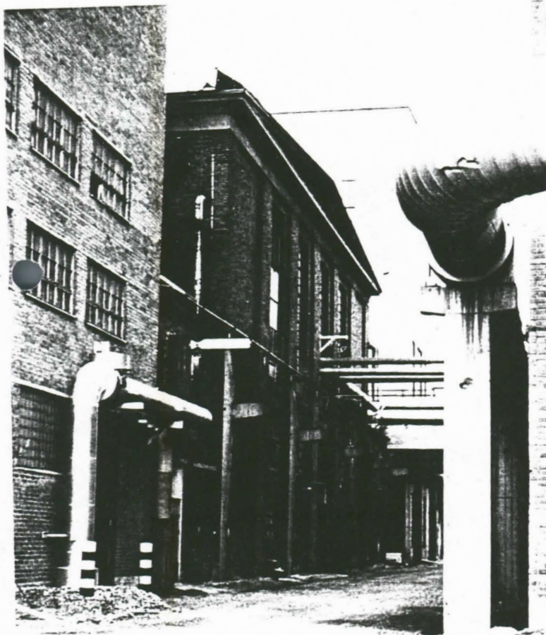
Kuva 5. Sulfiittiselluloosatehtaan massanlajitteluosasto alussa valmistunut pesuosasto. Massanlajitteluosaston luvun lopussa valmistunut valkaisuosasto. Etummaisena 1960-luvun takana häämöttää 1950-
