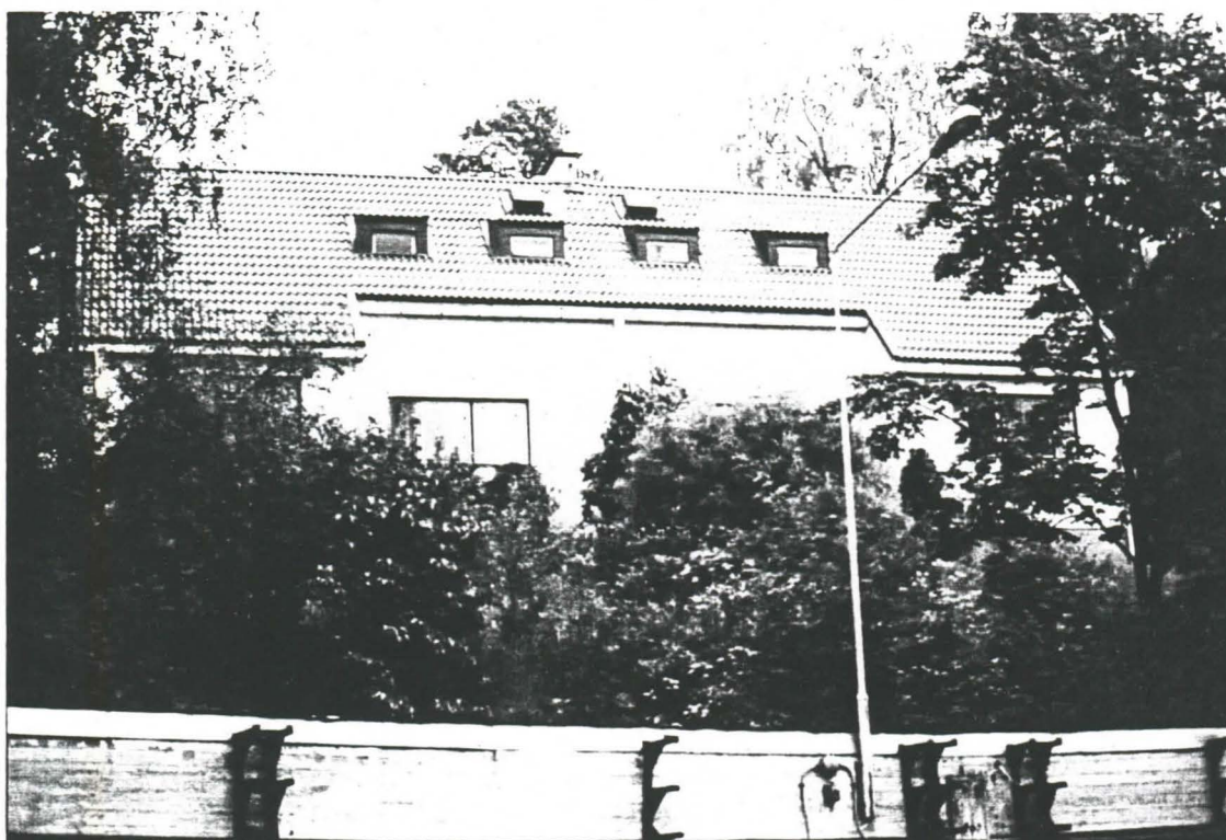
Kuva 24. Rantalinja. Lännestä. Kuvan alareunassa näkyy höyryputkitelinetä.
