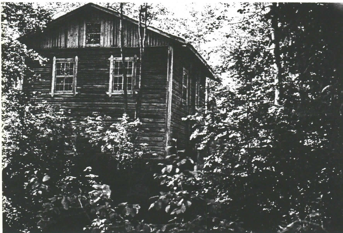
Kuva 1. Turpaan vesimylly. Padon alajuoksun puoleinen pääty. Oikealla näkyy betonirakenteista kanavaa (luultavasti turpiinikammio) sekä siitä toisen kerroksen kuljettimiin menevä valta-akseli.
