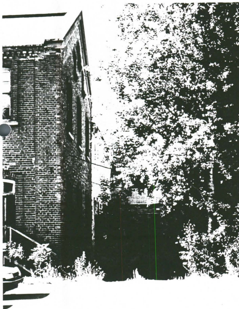
Kuva 16. Kalanterisalin ja lajitteluosaston pohjoispääty. Päätykolmiota jäsentävät, kuten monissa Tainionkosken paperi- ja rullatehtaan rakennuksissa esiintyvät pyörökkaari-ikkunat sekä julkisivuja karakterisoivat, tihein välein sijoitetut pieniruutuiset kaari-ikkunat. Ikkunanpielissä kuten räytäslistoissakin on tyyliteltyä tiilikoristelua.
