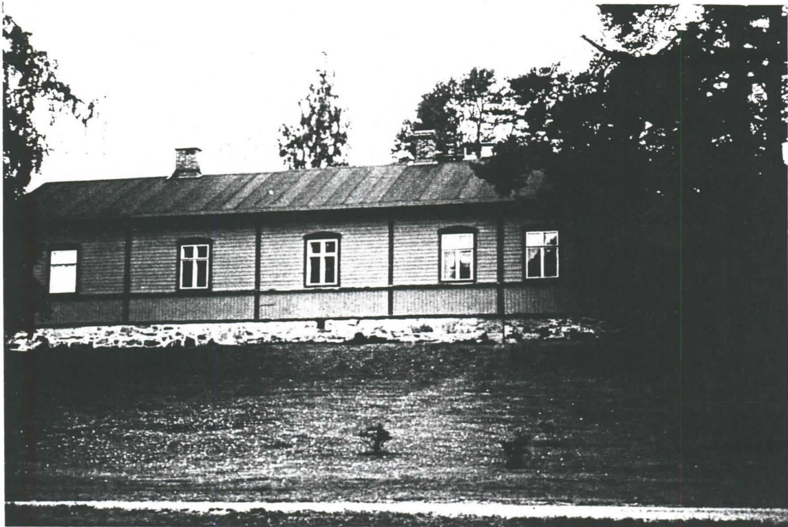
Kuva 6. Entinen teknisen johtajan asuinrakennus.
