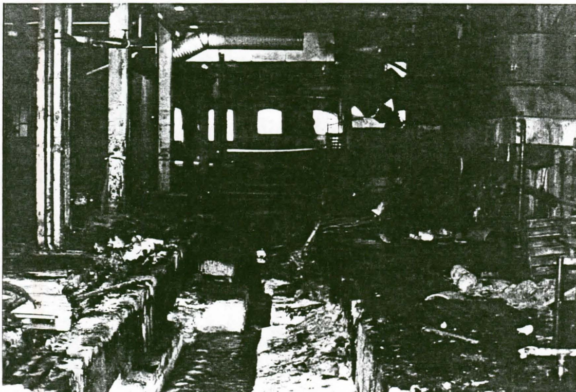
Kuva 2. Kartonkitehtaan konesalia. Poistetun kartonkikoneen perustukset
