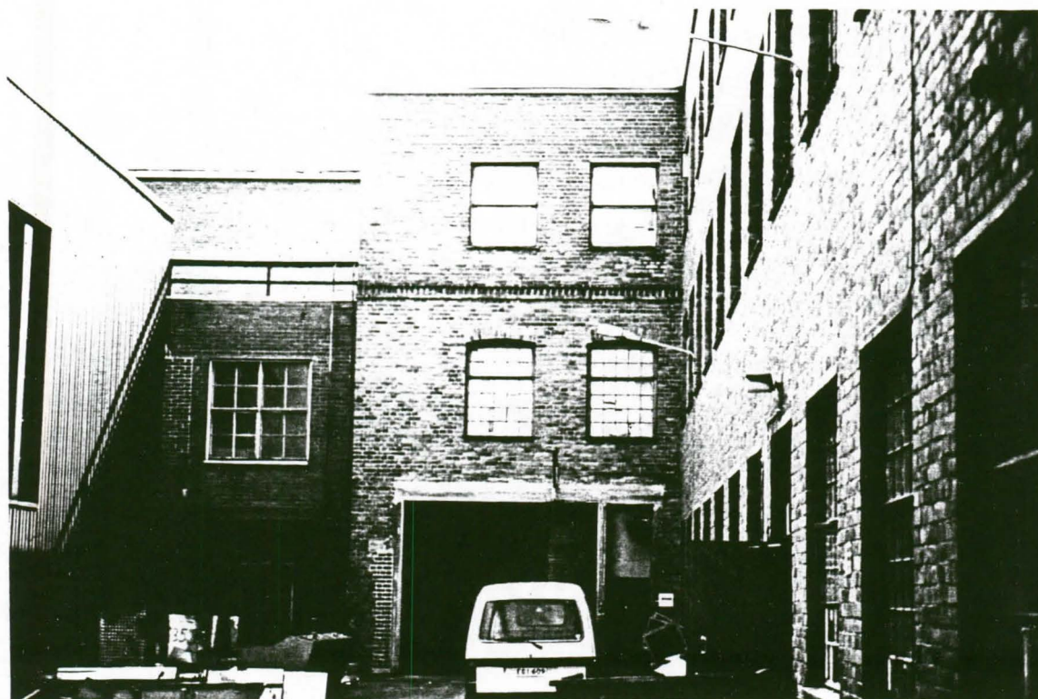
Kuva 6. Verstasrakennuksen itäpääty. Oikealla 1940-luvulla pystytetyn verstaan siipiosan itäosaa.
