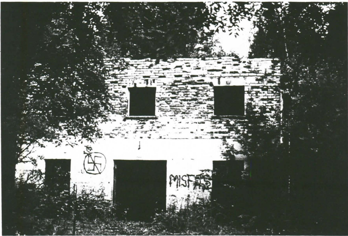
Kuva 1. Rutolan uusi ylivientilaitos
