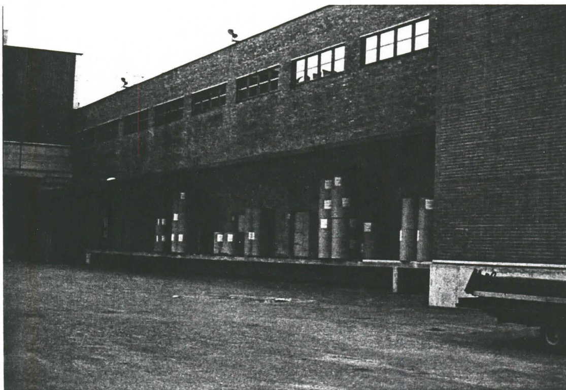
Kuva 37. Vanhan tuotevaraston lastauslaituri
