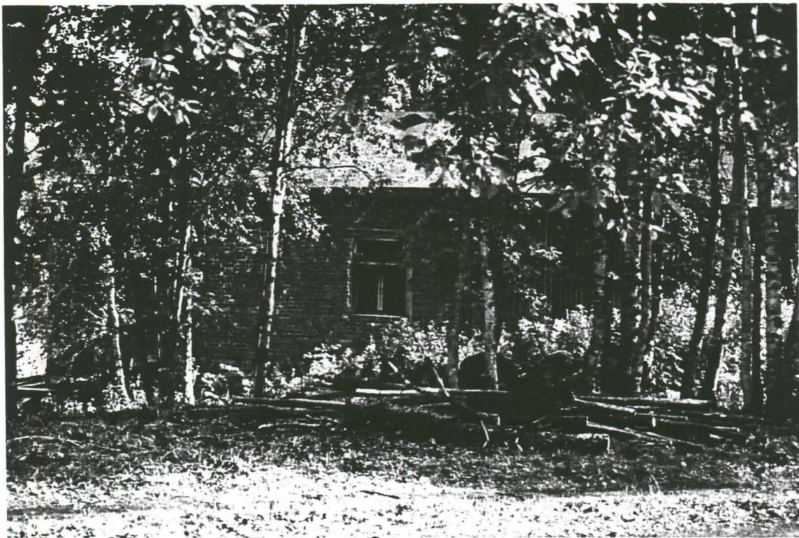
Kuva 3. Rutolan vanhan ylivientilaitoksen kohdalla oleva tiilinen rakennus, jossa on suurehko sorvi, jolla on mahdollisesti sorvattu rullaradan teloja. Sorvilla on ollut oma konehuone. Sorviin voiman välittänyt valta-akseli on säilynyt rakennuksen sisällä
