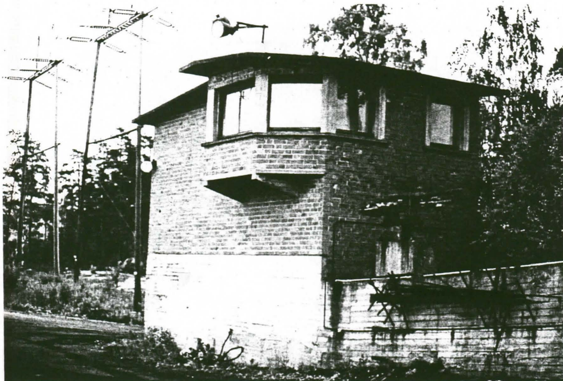
Kuva 5. Hiilikentältä voimalaitokseen hiiltä kuljettaneen laahakoneen ajokoppi konehuoneineen.
