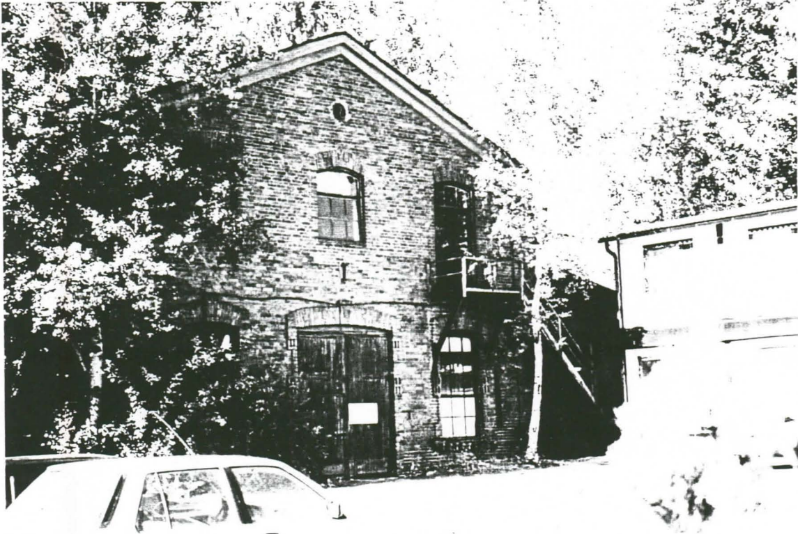
Kuva 17. Malliverstas. Huomaa ikkunanpielien ja ikkunalaudan tiiliornamentiikka.
