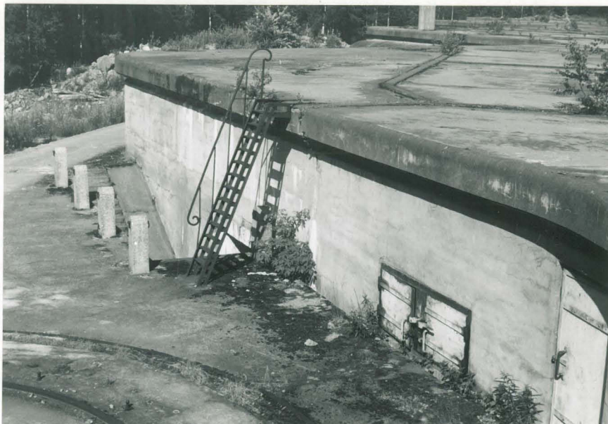
KUVA 56. Itä Villingin 254 mm:n patterin kellariin johtava porras ja hissihuoneen ovi. Portaan suojana on ollut valkograniittipilareista riippuva rautaketju. (S 7321)
