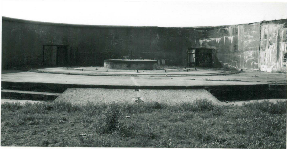
KUVA 38. Tykin perusta. Vasemmalla ammushissin ovi ja oikealla ampumatarvikekomero. (S 6807)
