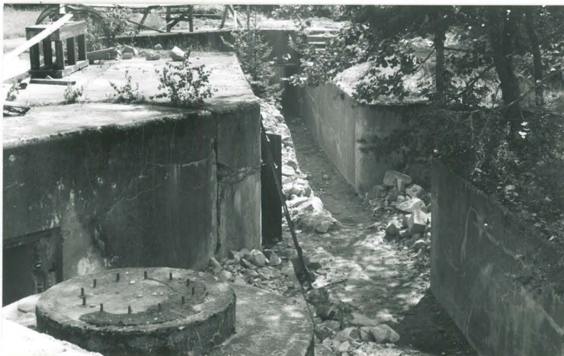
KUVA 54. 57 mm:n patterin tykin perusta, suojahuone, ajoluiska ja taustalla päähän johtava tunneli. (S 7298)
