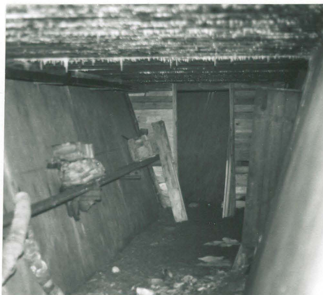
KUVA 21. Miehistösuojusta (Mie 2) johtava käytävä, joka levenee ylöspäin. (S 7288)
