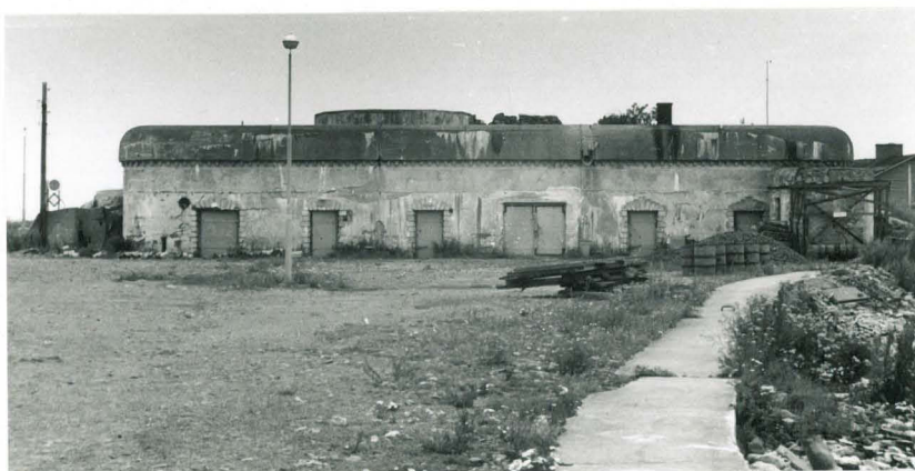
KUVA 29. Koneasema. Aseman katon yläpuolella näkyy valonheittimen valaisuasema ja sen oikealla puolella on ilmatorjunta-asema. (S 7660)
