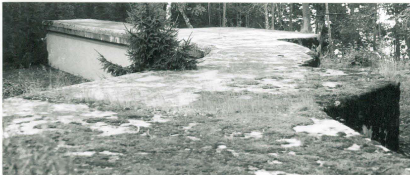
KUVA 58. Vuosaaren Skatanniemen patterin rintasuojaja, jossa ulkonemat ovat ampumatarvikekomeeroita. (S 7779)
