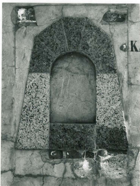
KUVA 15. Punagraniitilla ympäröity betoniin upotettu ikonin paikka (Itä Villinki, patteri Vil 254). (S 7315)
