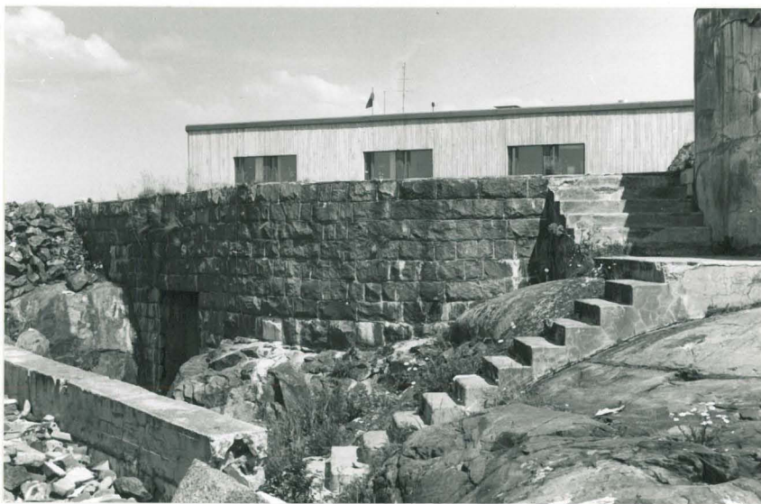
KUVA 33. Patterin alapuolella sijaitsevan tunnelin sisäänmeno. (S 6788)
