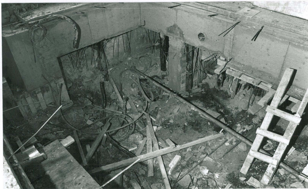
Kuva 40. Huone L. Tilanne ennen koekuoppia. Huone on paalutettu ja perustukset valettu. Kuva lounaasta.
