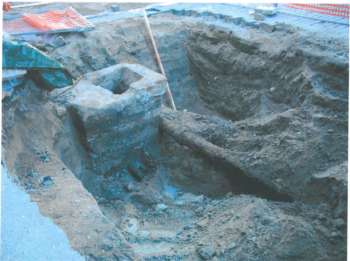
Kuva 284. Yliopistonkatu. Edessä sijaitsee betoniputki ja Yliopistonkadun ajoradalla viemärikaivo, kaivosta lähtevä rikkoutunut kreasiittiputki ja kaivon takana metallinen kaasuputki. Kuva kaakosta.
