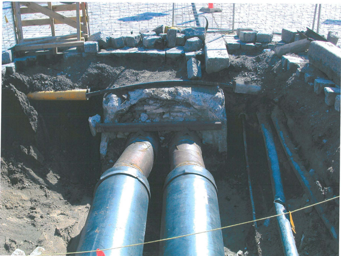
Kuva 234. Senaatintorin lounaisnurkka. Kaukolämpöputkikaivanto profiilin kohdalla. Profiili sijaitsi kuvan vasemmassa reunassa. uudet putket on asennettu etualalla. Kuva lännestä.
