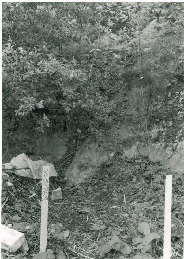
f. 270 024 Kuva 67. Koeoja 3 paalutettuna. Koeojan itäpää. Kuva idästä.
