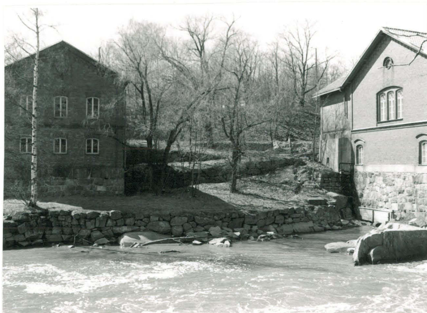
f. 270 008 Kuva 9. Entisten myllyn ja vesiturbiinilaitoksen välinen alue. Koeoja 5 sijaitsi alatasanteella. Kuva idästä.
