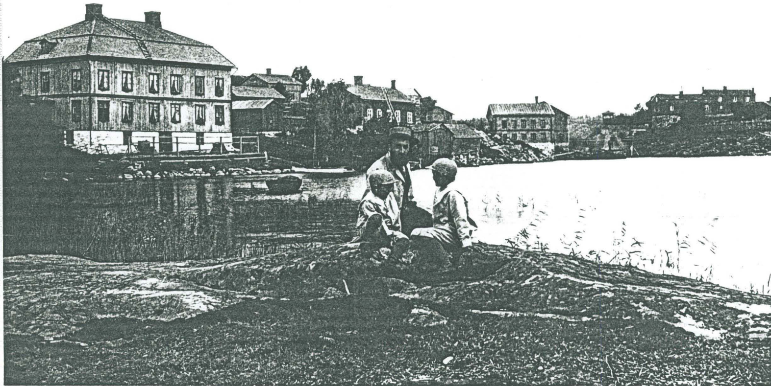
Kuva 108. Vanhankaupunginranta 1880-luvun lopulla. Kuvan vasemmalta reunalta: Handolinin värjäämö nykyisen energialaitoksen kohdalla, asuin- ja varastorakennuksia, mylly v:lta 1884 ja sen takana Helsingin vesilaitoksen vesiturbiinilaitos v:lta 1876. Kuninkaankartanon saarella sijaitsee Nordlinin, sittemmin Lindströmin, pesula. Kuva: F.A.V. Hjertzell/Helsingin kaupungin museo.
