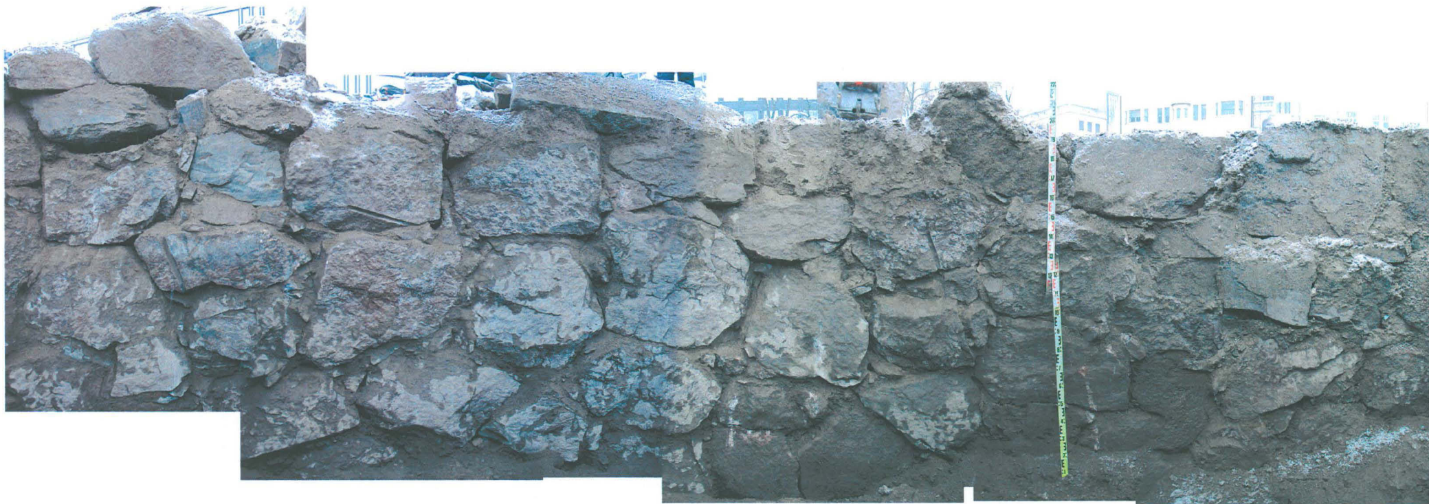
Kuva 71. Kaivon sisäseinä lännestä pohjoisen kautta etelään. Kuvapanoraama. 29.1.2005.
