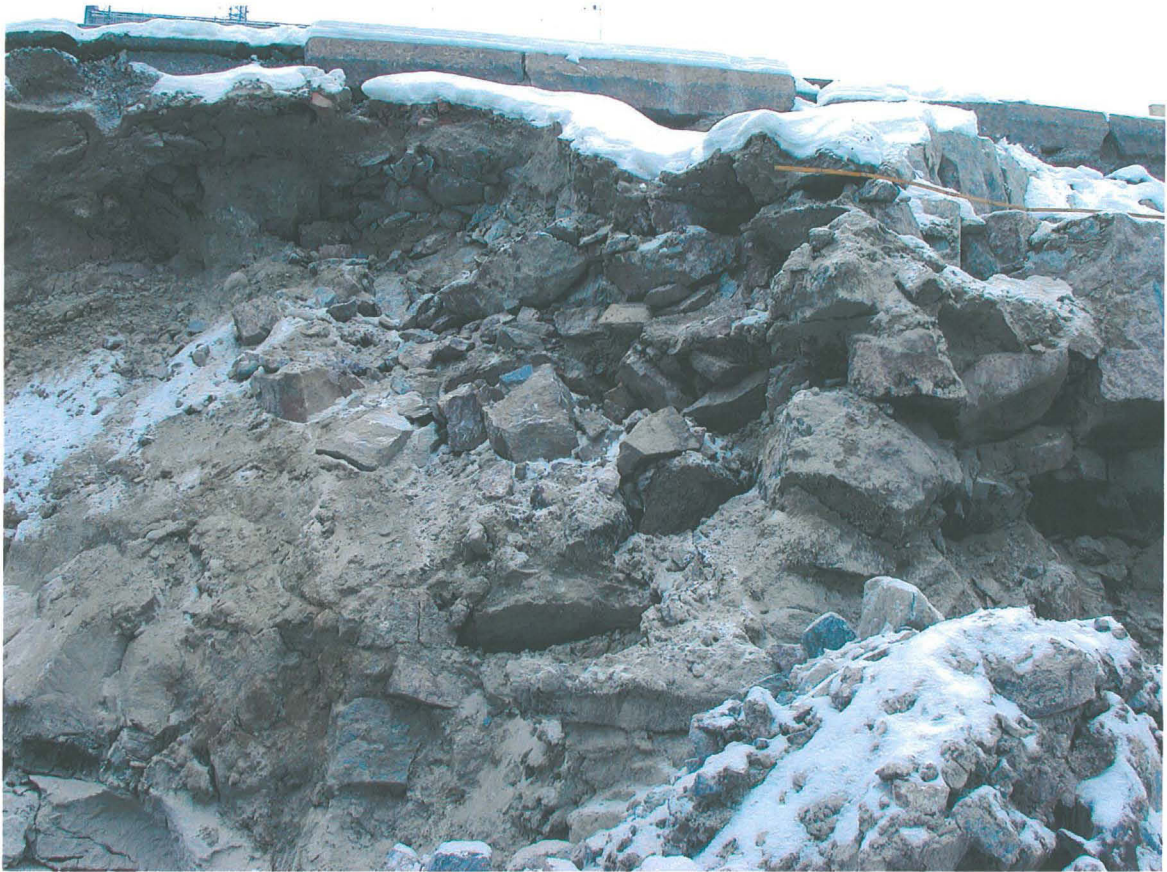
Kuva 54. Kaivon eteläseinää. Keskellä näkyy kaivon kiviarkun ulko-osien irtonaista kivimassaa. Kuva kaakosta. 27.1.2004.
