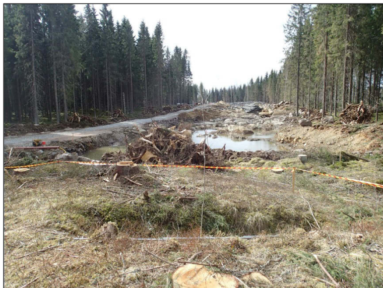
Rännihaudan sijainti tietyömaa-alueella.
