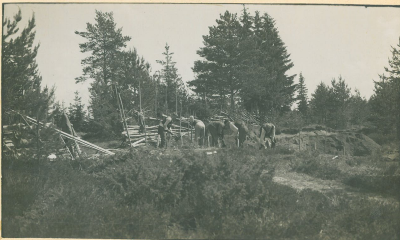
Sipilän laakso kaivaus.
