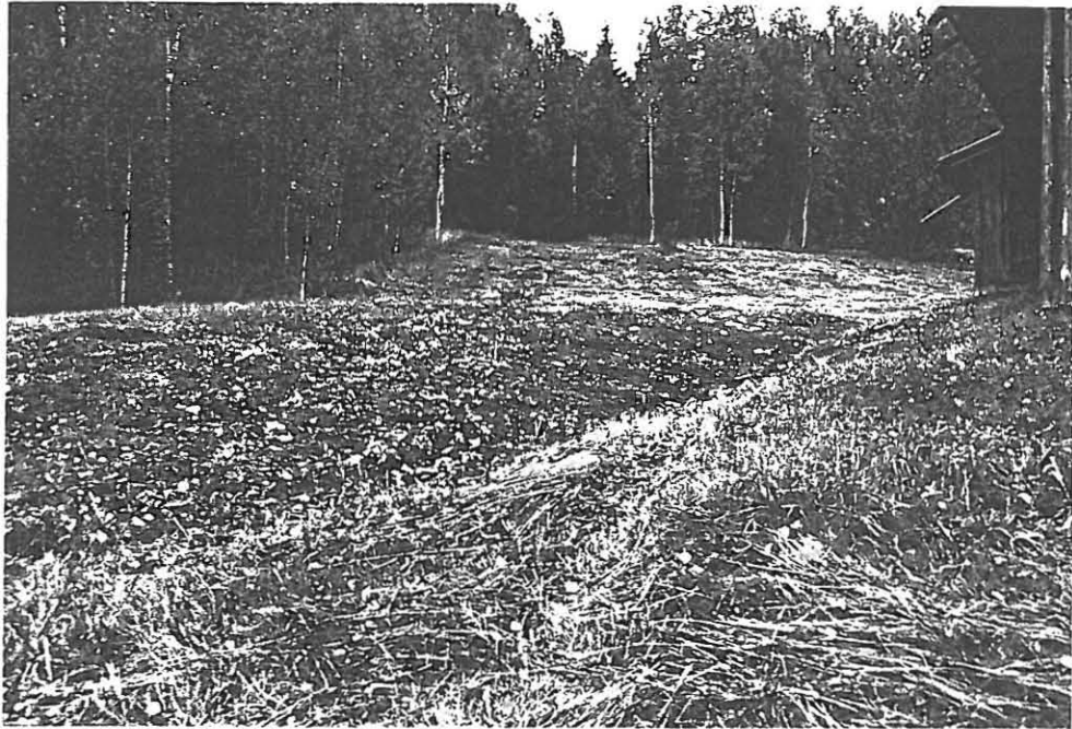
Kuva 5. Päärakennuksen taakse on kaivettu leikkaus pintavesien poistamiseksi. Leikkauspinnassa kasvaa pääasiassa metsäkasvillisuutta.
