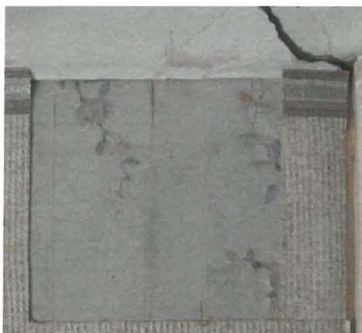
KUVA 18. Reuna paikkauksen jälkeen.
