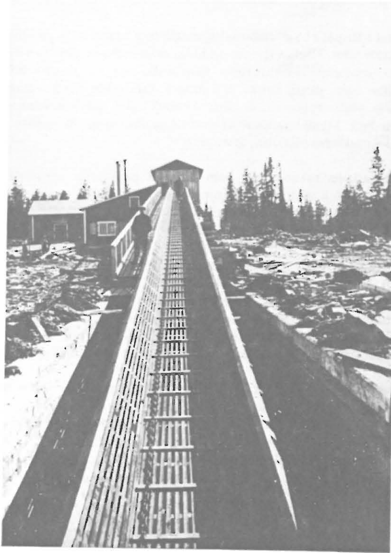
Kuva 31. Akanlahden tukinsiirtosiirtolaite Posiolla vuonna 1936. Siirtolaitteella nostettiin puut uittoränniin. Kuva: metsähallitus.
