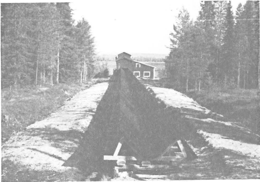
005 tukinsiirtolaitos ja uittoruuhia korjaustyön aikana
