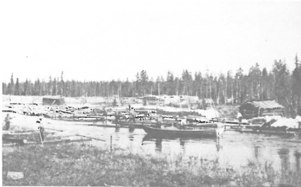
Kuva 30. Meltauksen hoitoalueen Haarainvaaran työmaa toukokuussa 1953. Kuva: metsähallitus.
