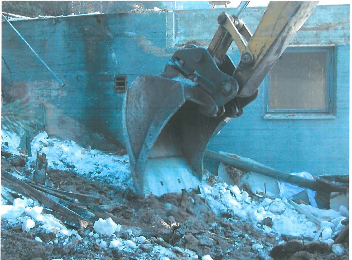
Virrat, Liedenpohja, Rieskaniemen tila. Työhankeeseen valvonta rakennuksen purkutyömaalla maaliskuussa 2006. 14.3.2006, Ulla Lähdesmäki.
