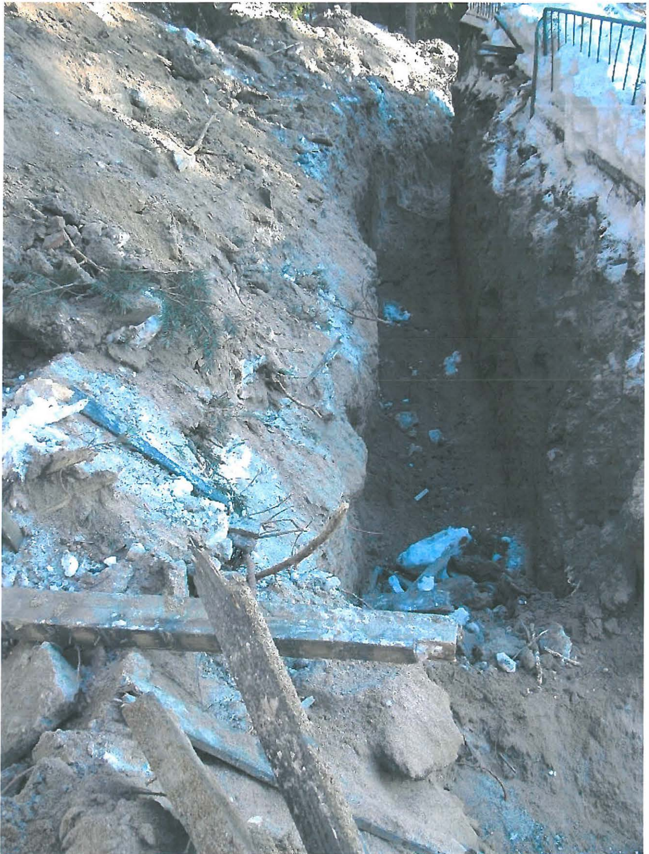
Virrat, Liedempohja, Syvälahti. Osa rakennuksen perustuksesta kaivettu esille valvonnassa. Kuvattu lännestä. 14.3.2006, Ulla Lähdesmäki.
