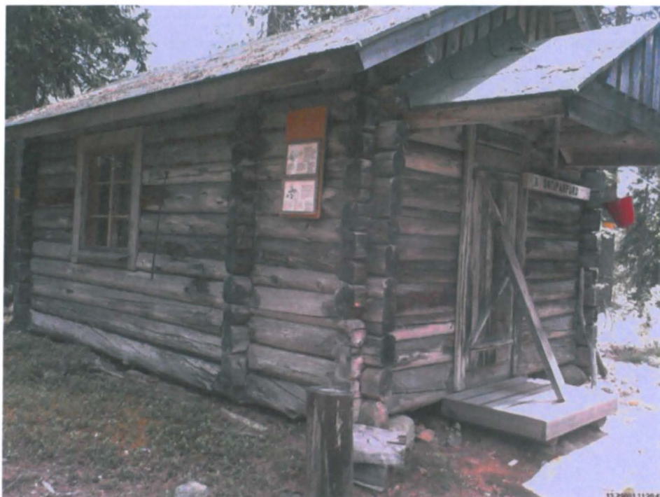
Kuva 208. Ontipanpuron kämppä, kuvattu pohjoisesta.
