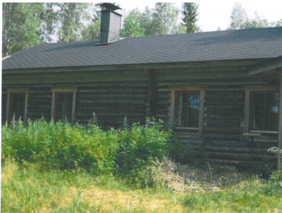
Kuva 207. Ruotin kämppä, kuvattu pohjoisesta.
