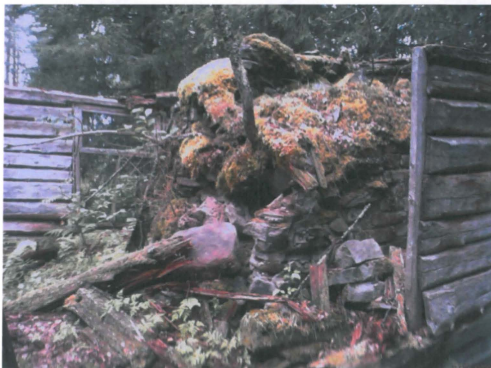
Kuva 244. Uunin jäänteitä rakenteen sisällä.
