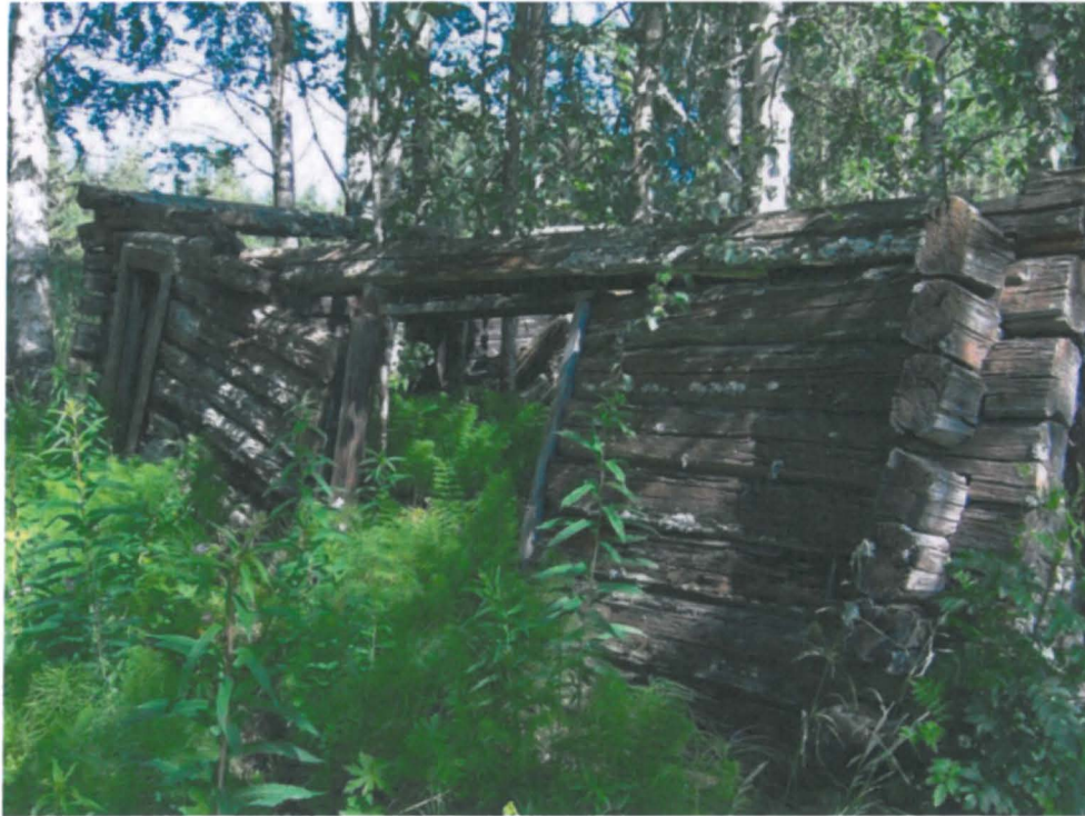
Kuva 240. Rakennuksen jäännös, kuvattu lounaasta.
