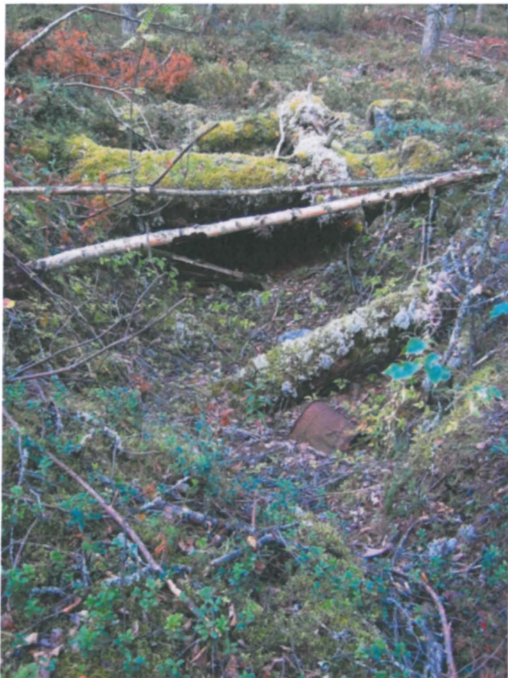
Kuva 161. Sota-aikaisia rakenteita, kuvattu pohjoisesta.
