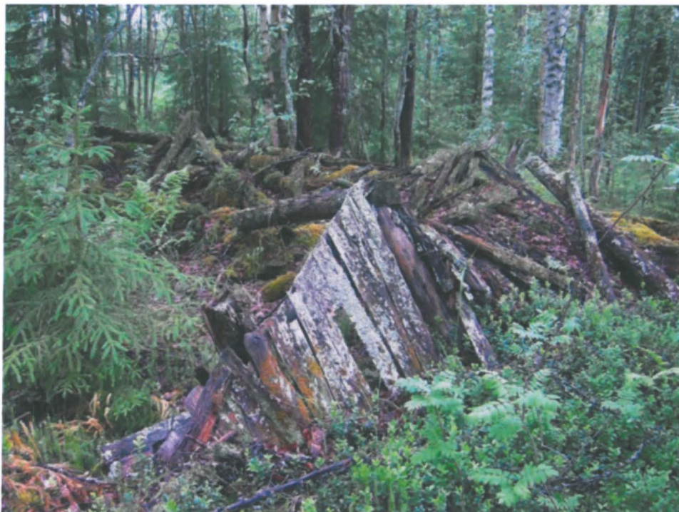
Kuva 229. Romahtanut rakennus, kuvattu luoteesta.
