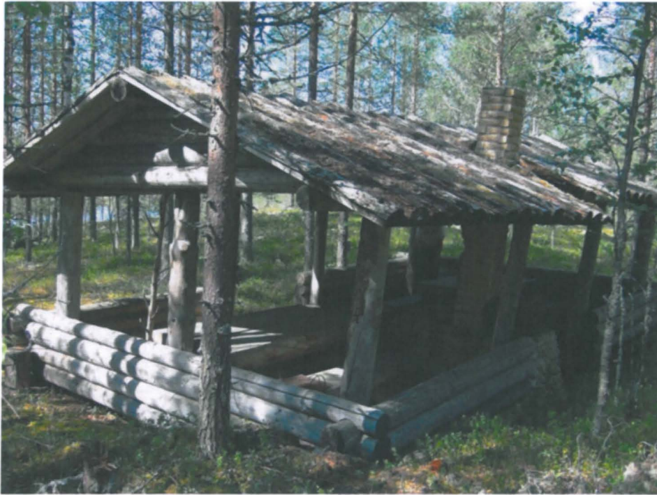
Kuva 206. Stora Enson rakennuttama juhla-katos, kuvattu koillisesta.
