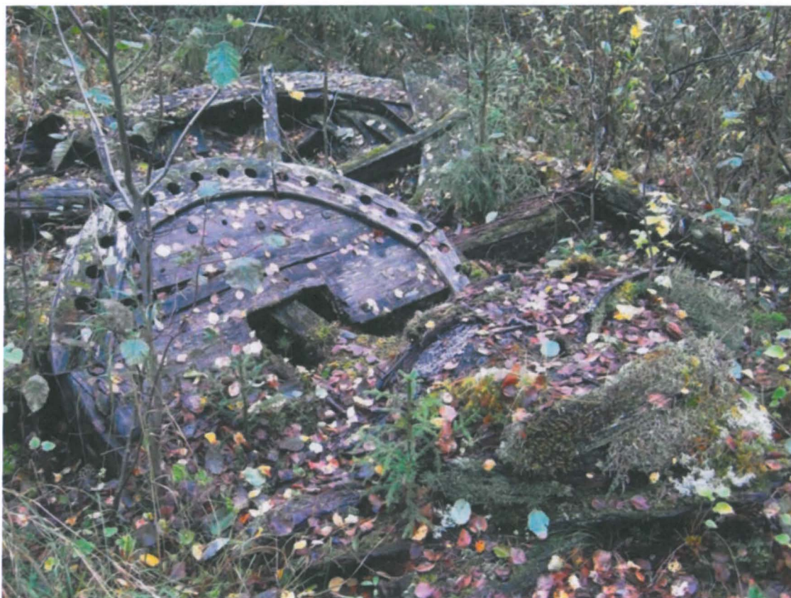
Kuva 279. Myllyn puurakenteita, kuvattu kaakosta.
