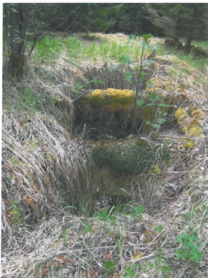
Kuva 214. Pohjarakenteita, kuvattu koillisesta.
