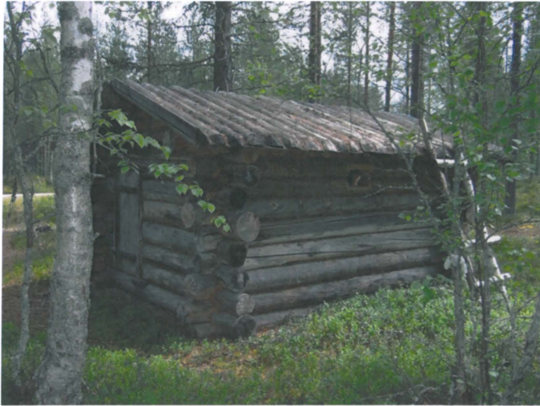
Kuva 204. Metsäsauna, kuvattu luoteesta.
