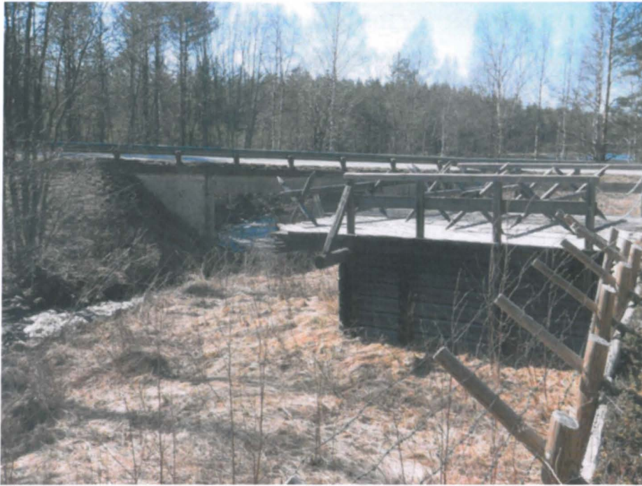
Kuva 131. Sillan rekonstruktio, kuvattu idästä.
