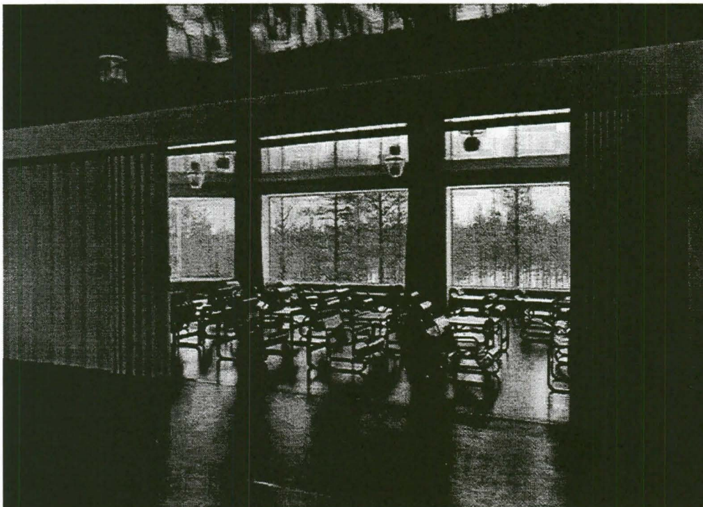
Näkymä ruokasalista seurustelutilaan 1930-luvulla. 50-003-419 AAS.
