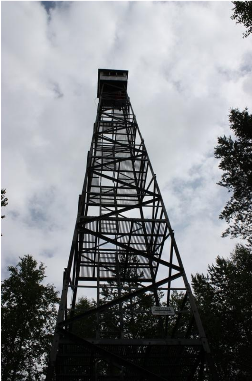
Kuva 221. Juntinvaaran palotorni, kuvattu länsilounaasta.
