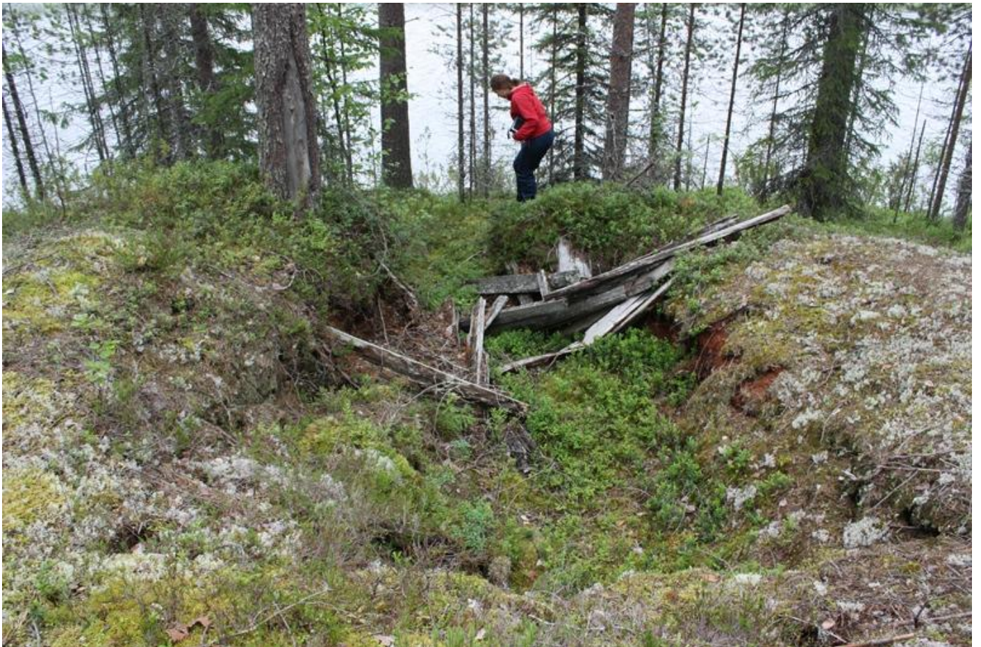
Kuva 122. Kellarin pohja, kuvattu lounaasta.
