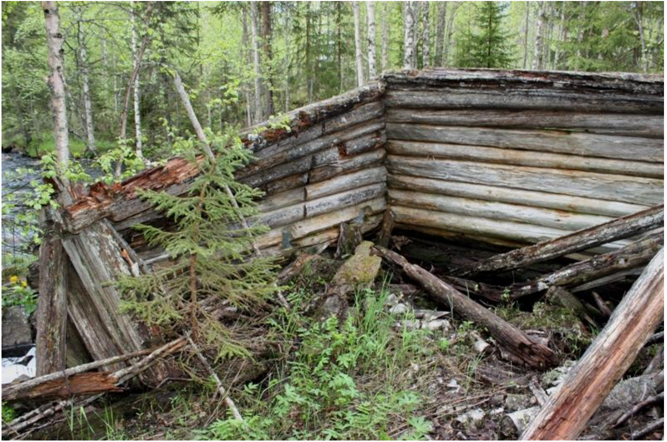
Kuva 145. Myllyn sisäpuoli, kuvattu idästä.
