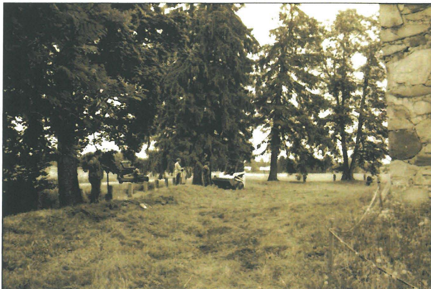
3 Pälkäne rauniokirkko. Työkuva. Maavallia madalletaan ja maanpintaa tasoitetaan. Luoteesta.
