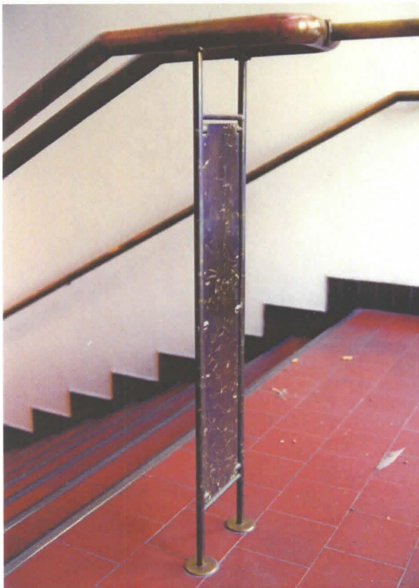
Sisäänkäynti. Porras sisäänkäynnin tasolle. Kaiteen yksityiskohtia.
