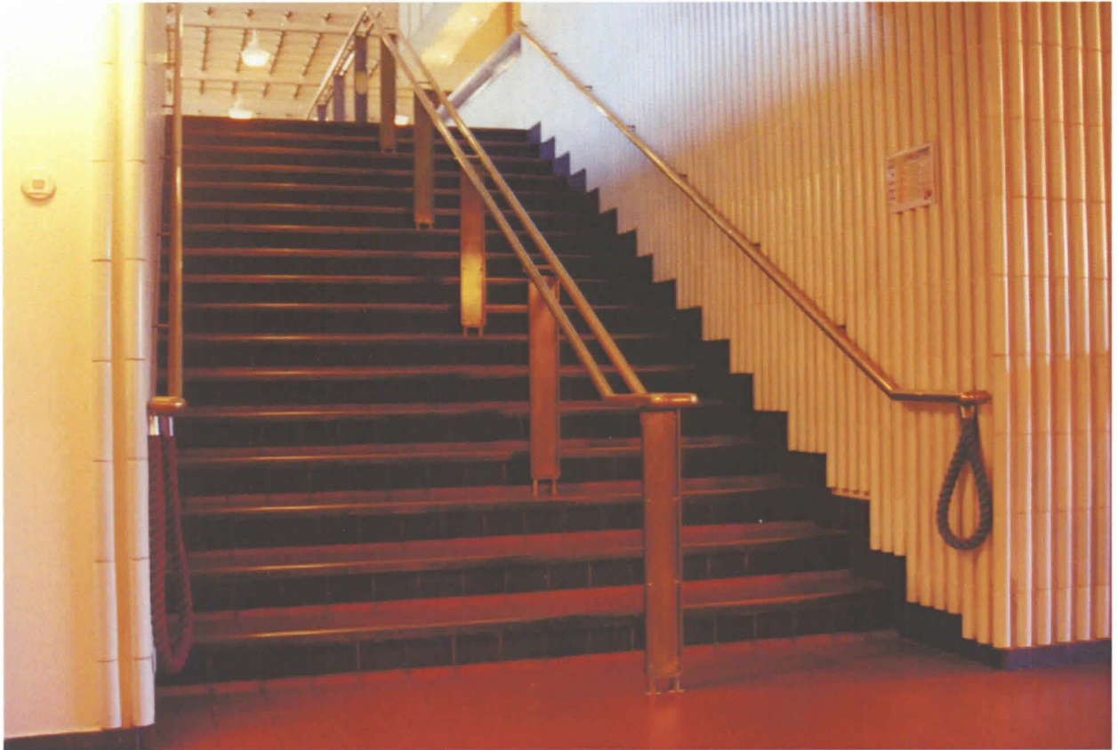
Porras F2. Näkymä etelään (1. kerroksesta).
