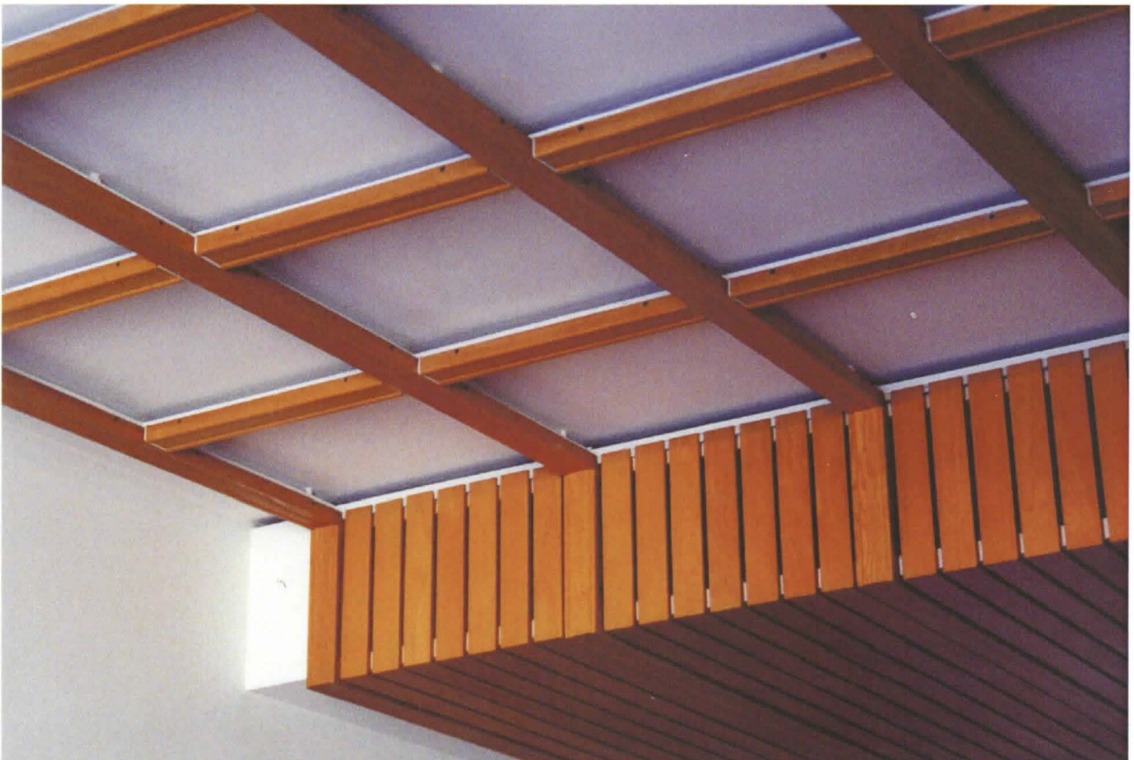
Johtokoururuudukon ja länsiosan kattoverhouksen yksityiskohtia.
