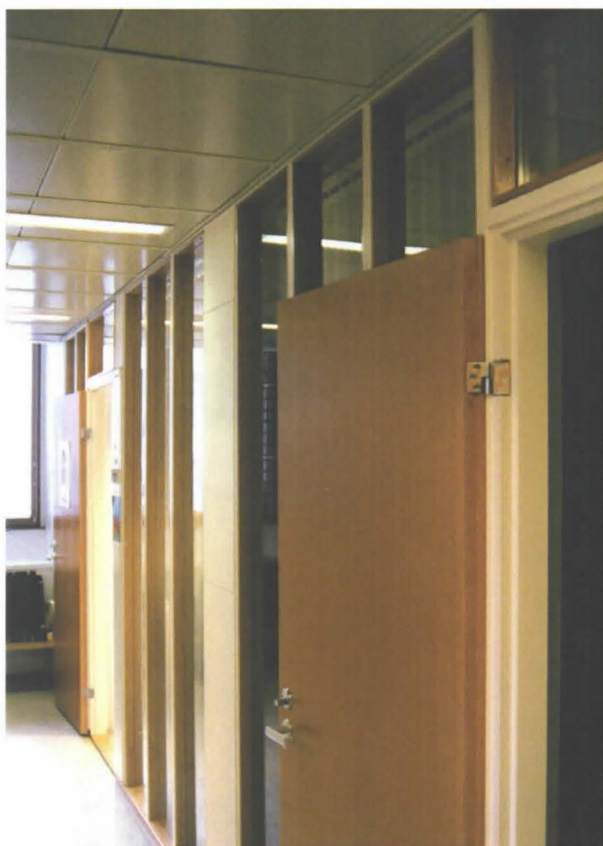
Toimistohuoneiden (389, 390) vastainen seinä.
