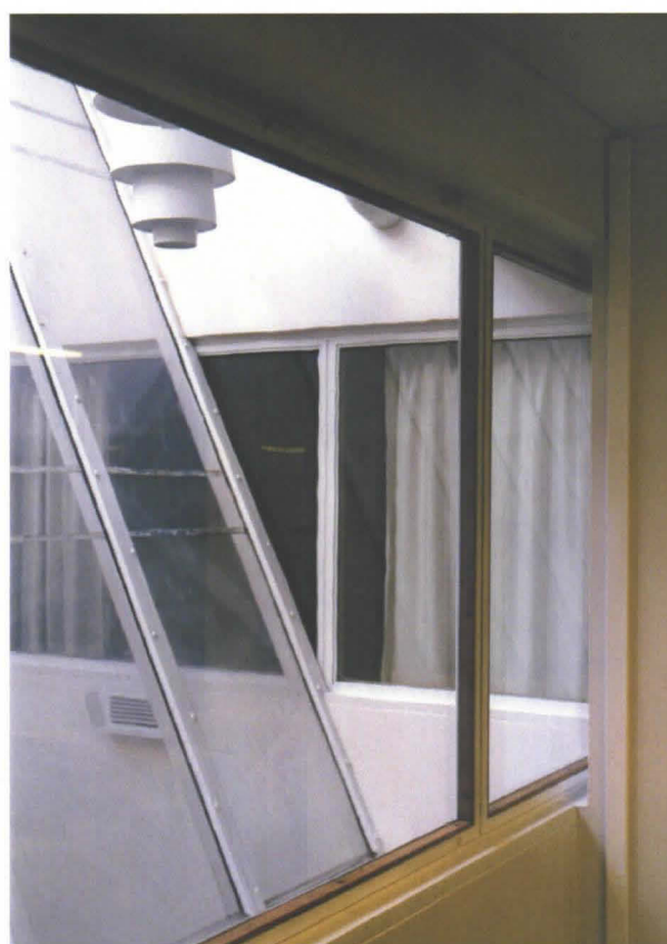
Eteläosa. Sisäikkunat Kelahallin (105) sisempien ja ulompien kattoikkunoiden väliseen tilaan.
