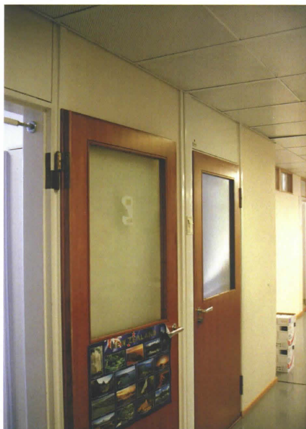
Ovet toimistohuoneisiin (316J, 316H).
