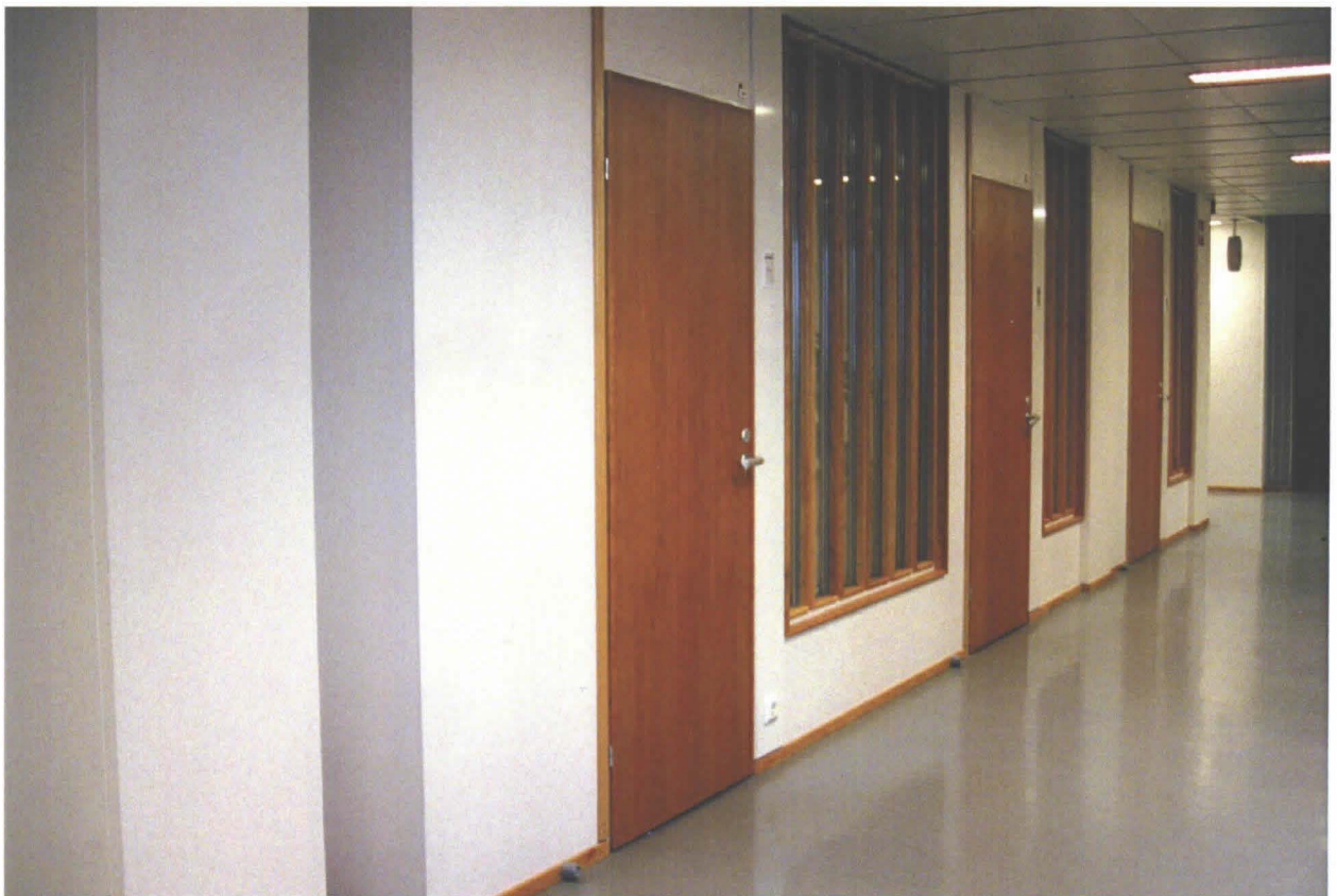
Pohjoisosa. Toimistohuoneiden (344, 345, 346) vastainen eteläseinä.
