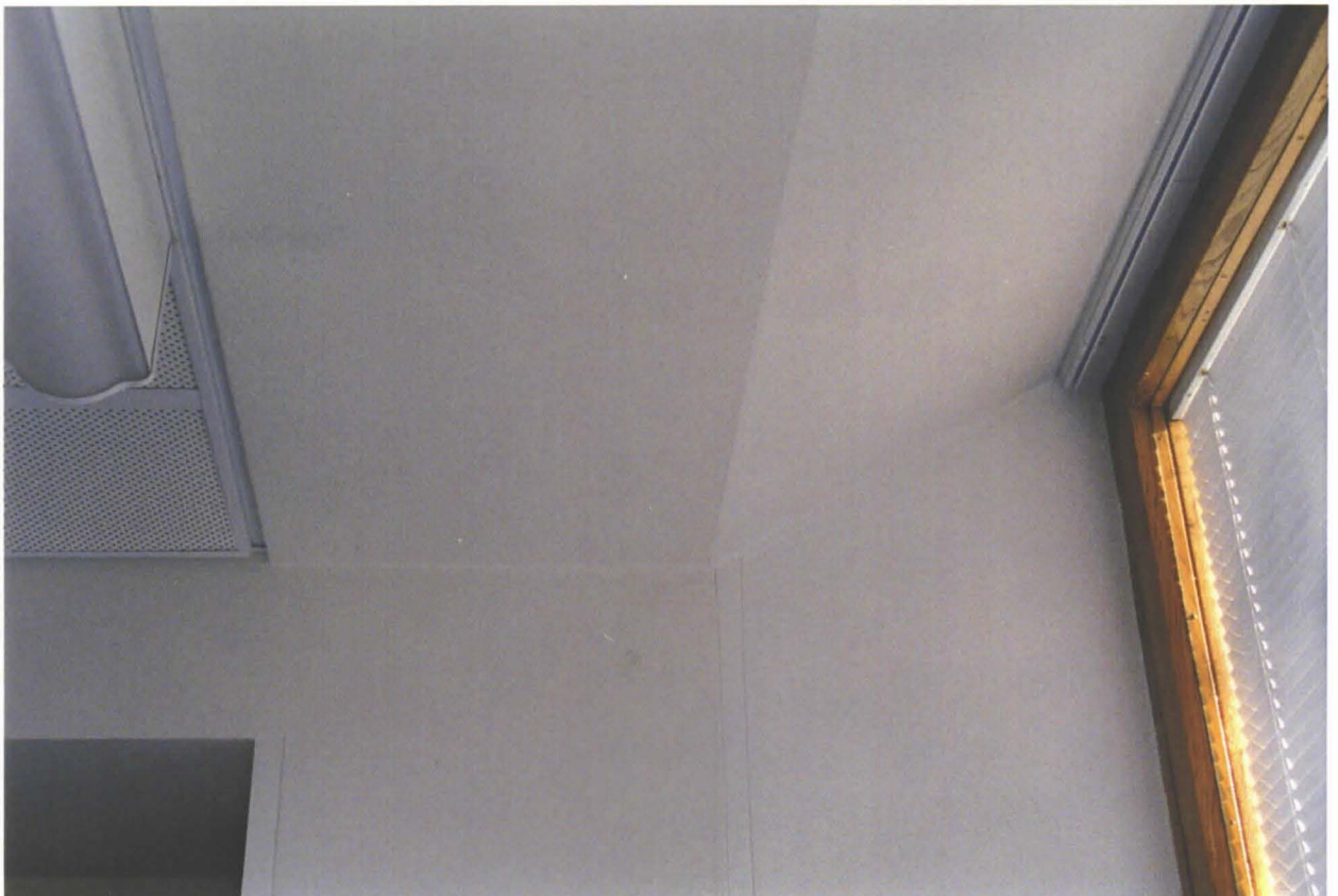
Palkki ja välipohjan viiste ulkoseinustalla.
