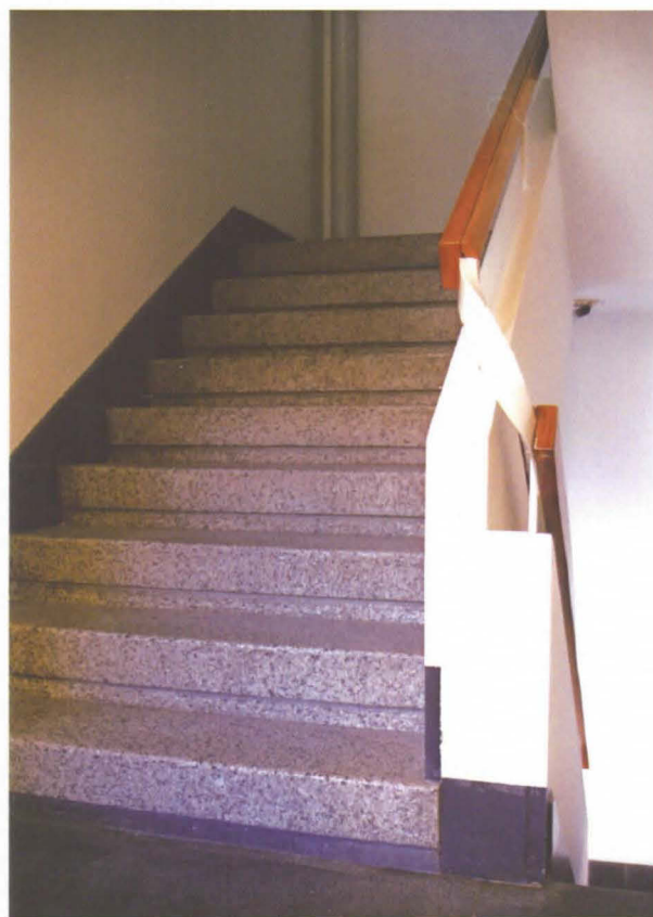
Näkymä länteen (2. kerroksesta).
