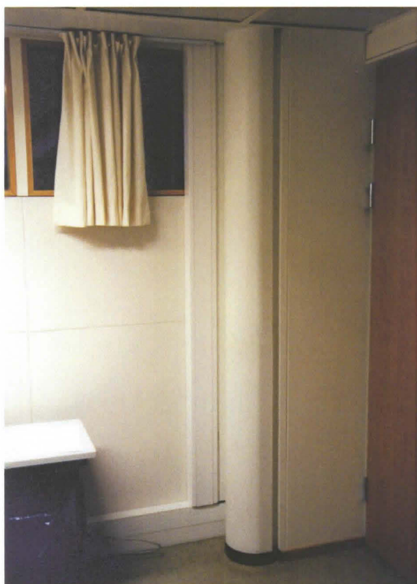
Itäseinästä ulkoneva pilari ja putkikotelo.
