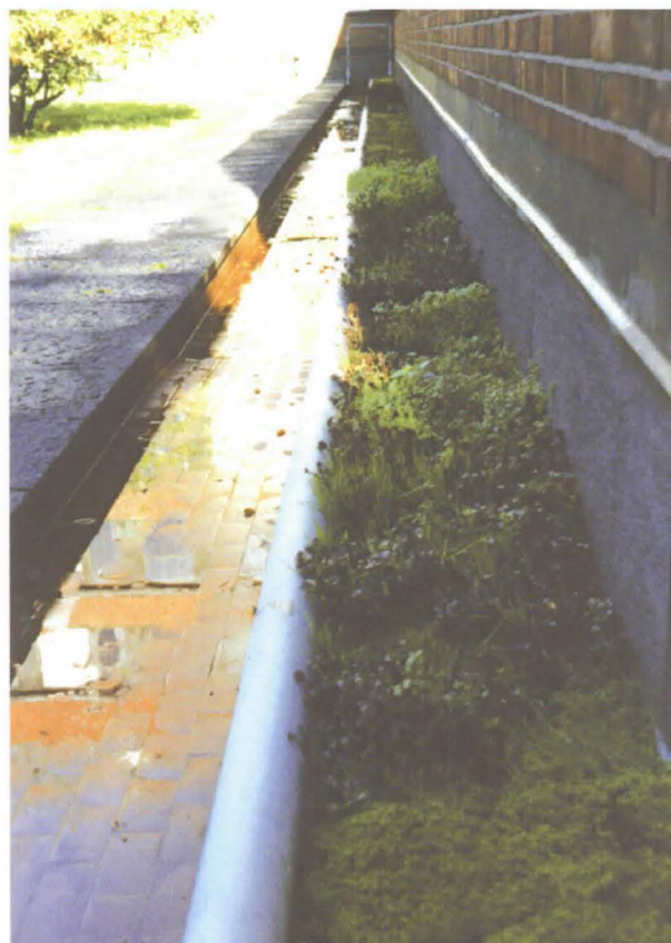
Vesikouru III lohkon länsisivulla.
