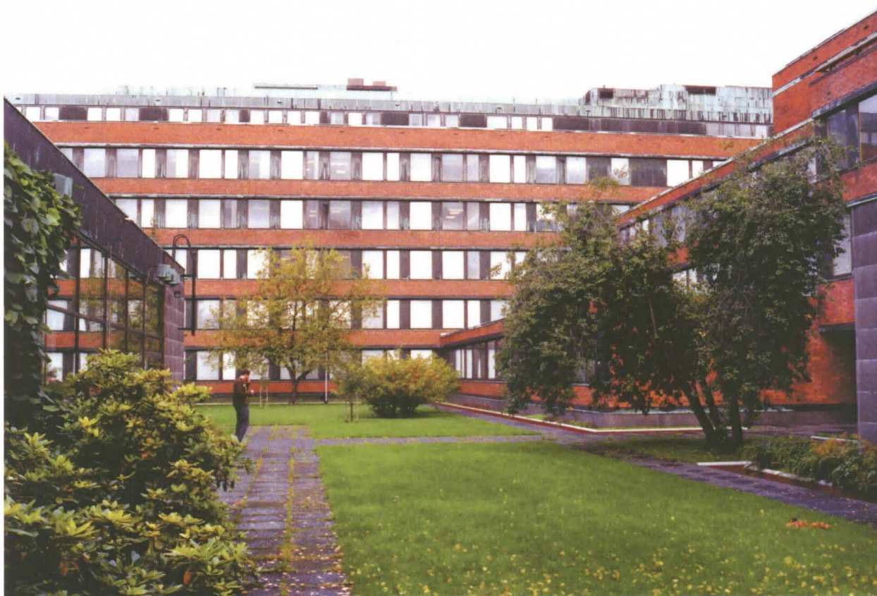
II lohkon eteläisivu.
