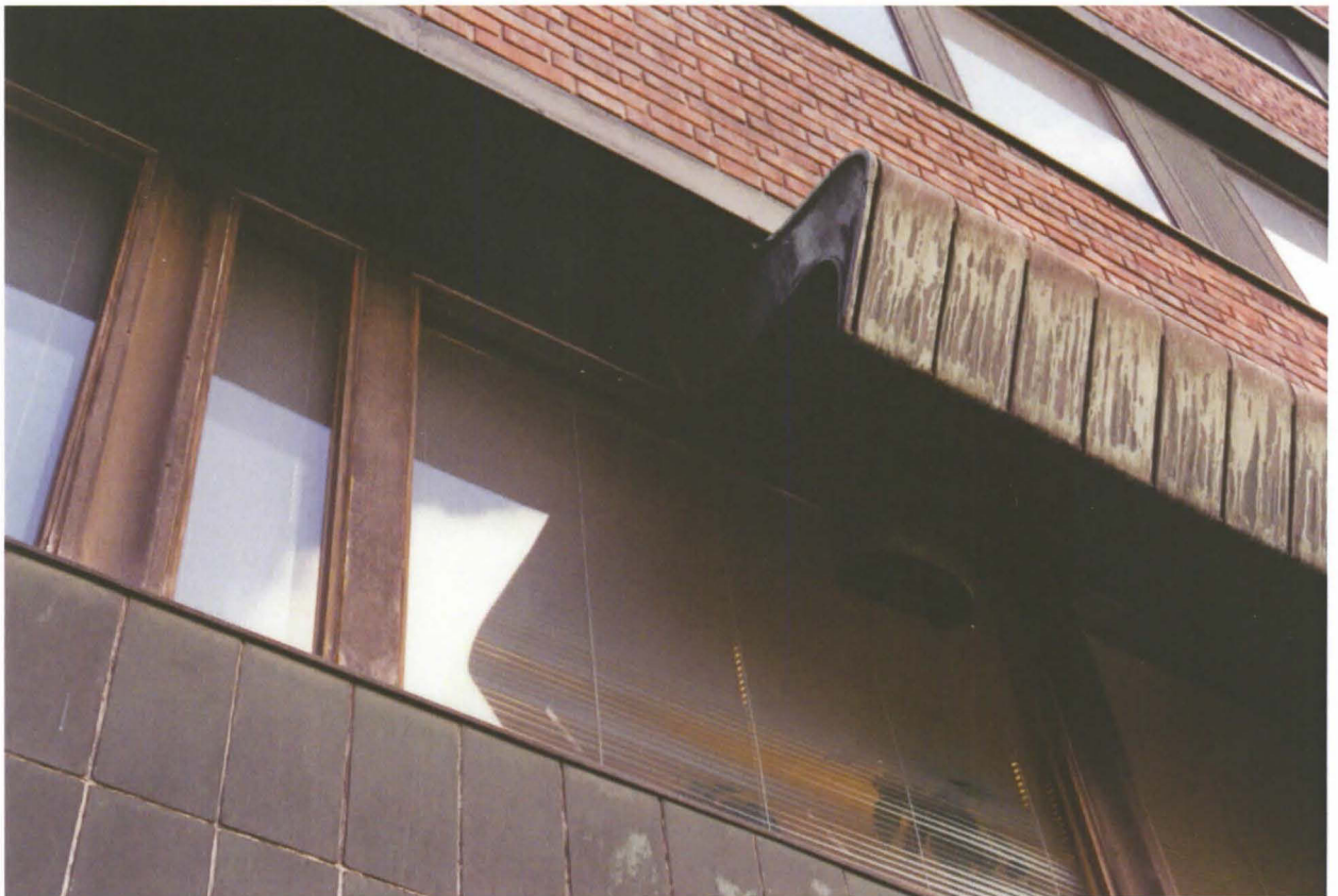
III lohkon 2. kerroksen ikkunoiden ja pääsisäänkäynnin katoksen yksityiskohtia.
