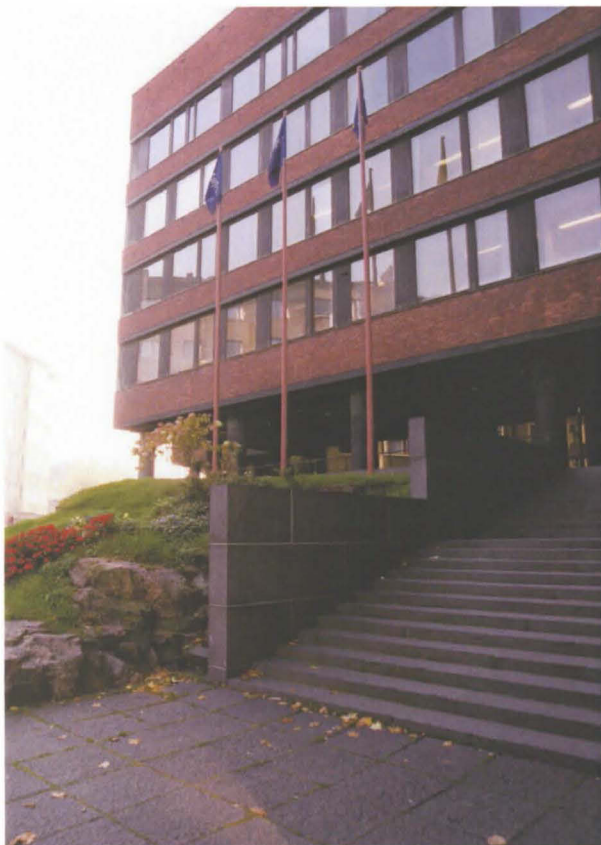
Näkymä etelään/länteen. Porras pylväikköön.
