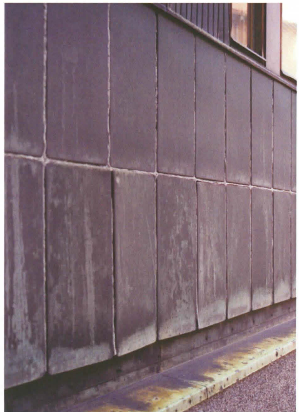
III lohkon 2. kerroksen rintamuurin yksityiskohtia.
