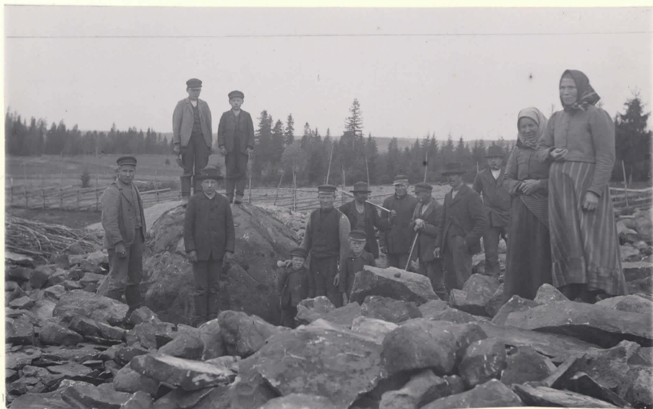
Harjavalta, Fortunan W. Jaakolan vare n o I. Keskeä on pieni silmäkivi. miehet seisovat pohjassa tuennitulla maalla. Valok. suunnassa idästä länteen lev. 2307.
