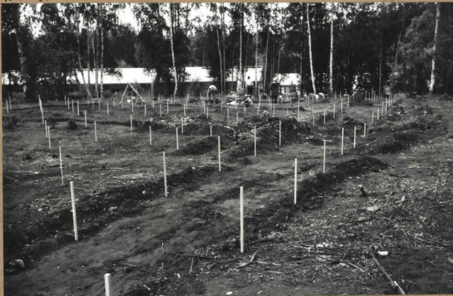
109337 KAIVAUSSKOTTEE PÄÄLUTETTUNA. E-W. SL.
