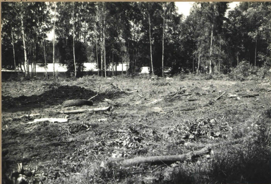
109329 YLEISKUVA KAIVAUSSKOTTEESTA PUIDEN KAATAMISEN JÄLKEEN. E-W. SL.
