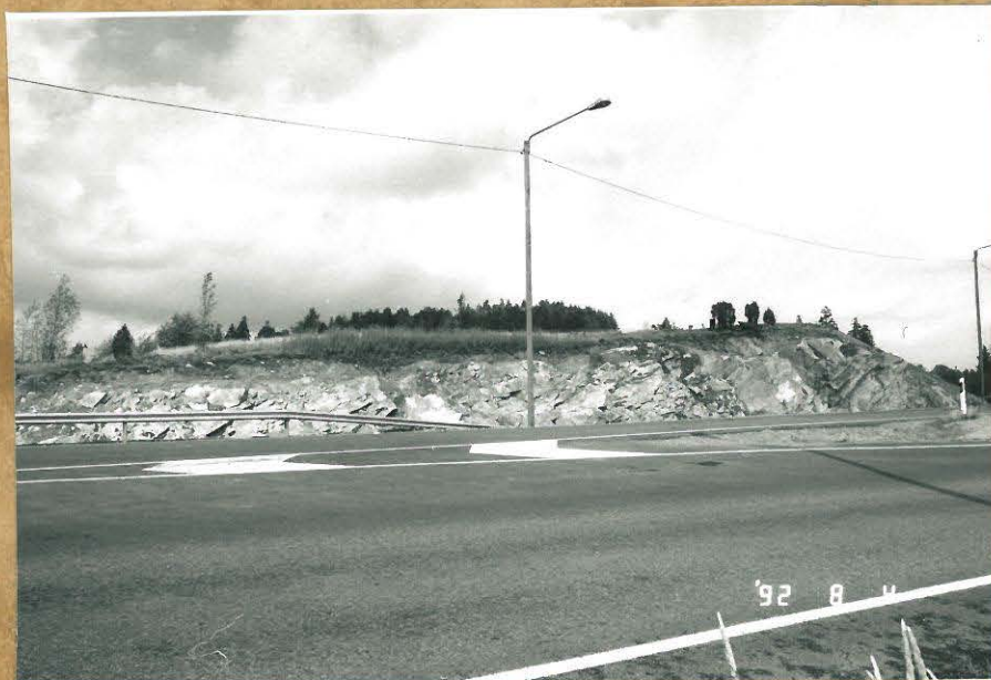
K.1 Kiveys Turku-Helsinki -tien takaa katsottuna. SW-NE. Kiveys sijaitsi katajien kohdalla. Kuva Timo Pärssinen.
