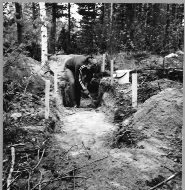
F.68592 Työkuva. Koojan B tasoa 2 kaivetaan. Pohjoisesta.
