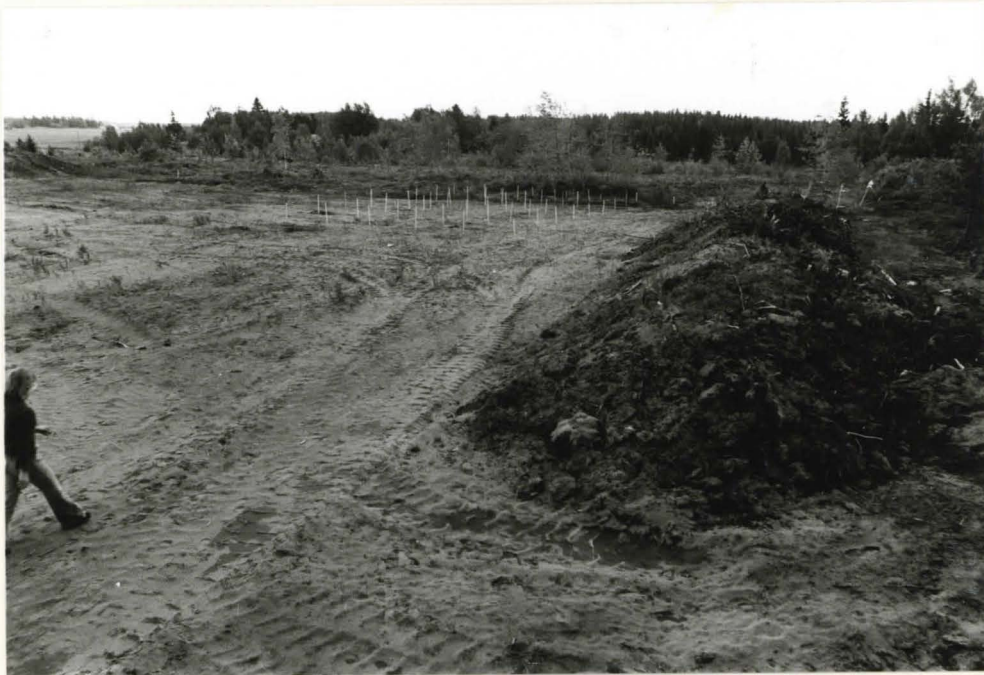
Kaivausalueen N-osa paalutettuna. NW. 9.6. Neg. 1785.
