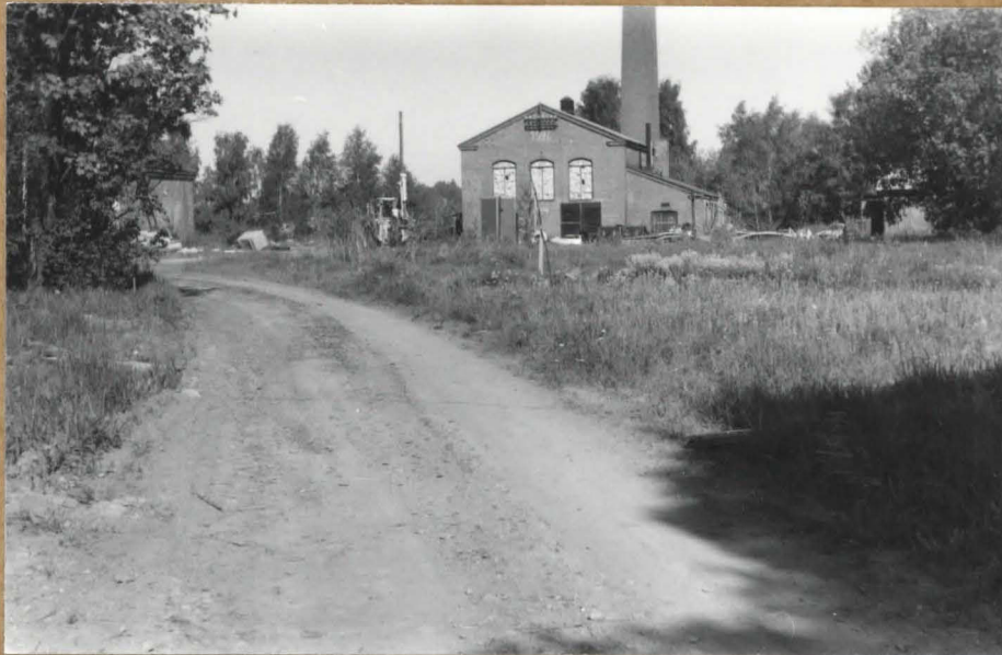
K.107 Kaivausalue ennen avaamista, kaakosta.
