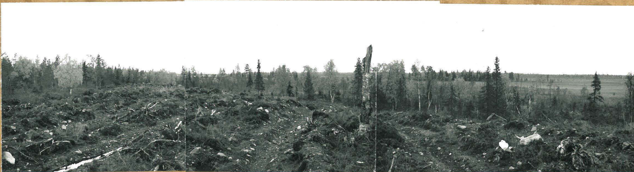
f. 90692 YLEISKUVA, SE
