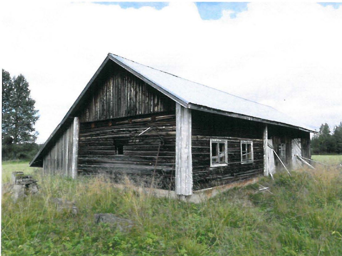
Navettaan on uusittu peltikatto. Kuv. T. Karjalainen
