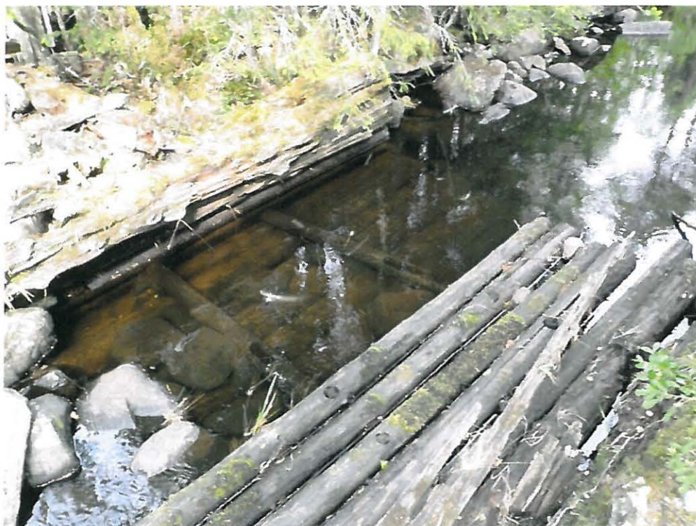
Uittopadon rakenteita ojan pohjassa. Kuv. T. Karjalainen
