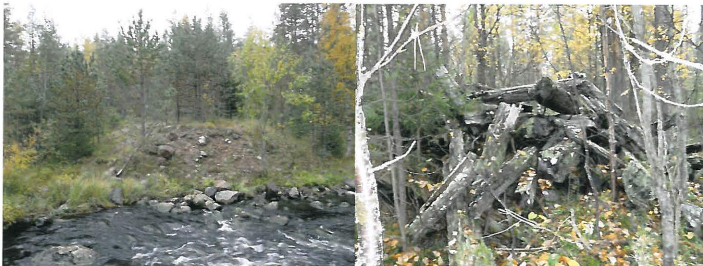
Tammen maa- ja puurakenteita. Kuv. T. Karjalainen
