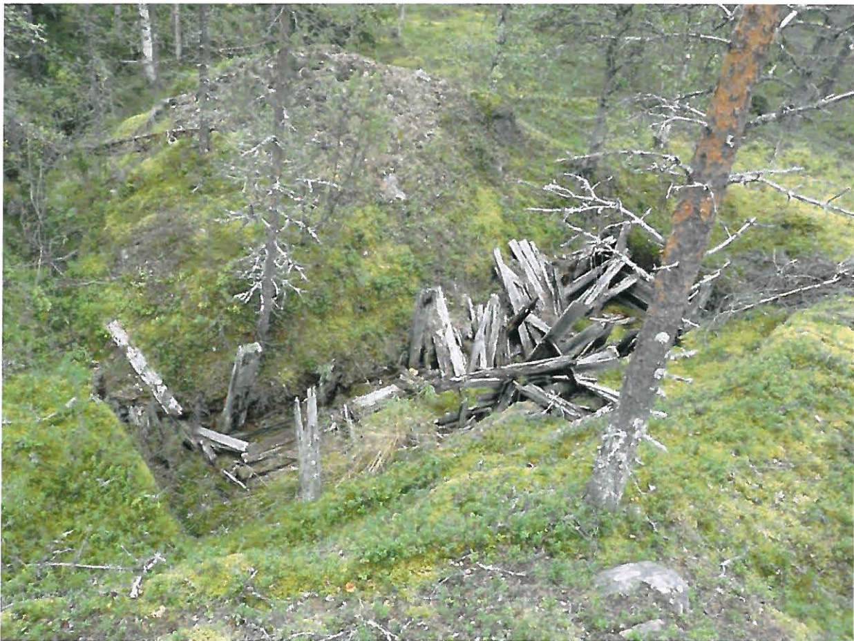
Taimikellarin maavallit ovat massiivisia ja rakennelma on luultavasti tehty koneellisesti. Kuv. T. Karjalainen
