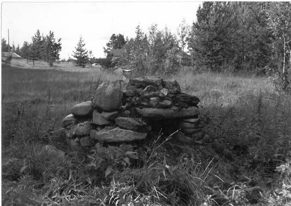
Kuva 133. Kuusijärvi, Kuusiniemi ( ). Riihen kiuas, savella tiivistetty / muurattu. Kuva idästä.
