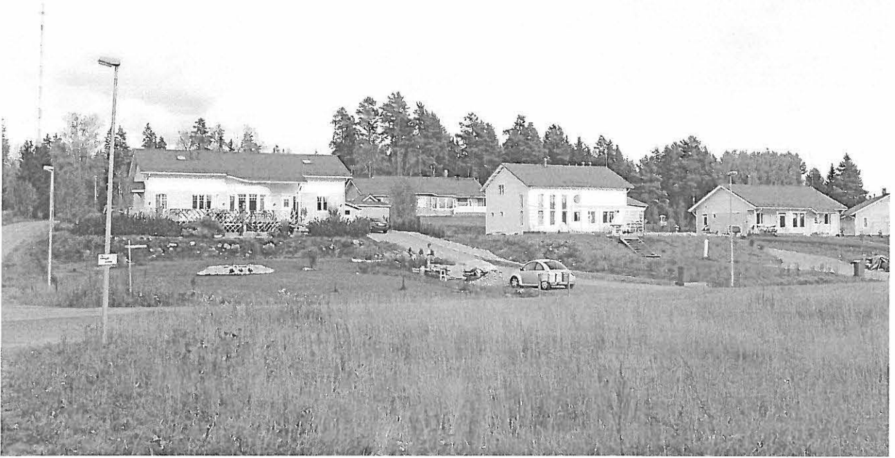
DG 223:1. Kotopelto-Kuoppamäki. Asuinpaikan päälle rakennettuja omakotitaloja, lounaasta.29.9.2008.
