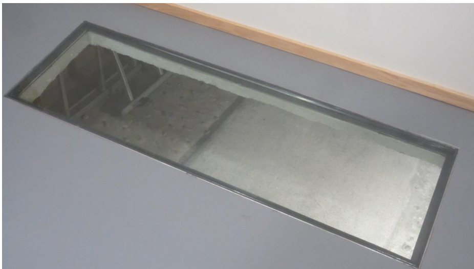
Kokoushuoneen lattiassa ikkuna lattian alle jätetylle luiskalle (AAM / Malmberg).
