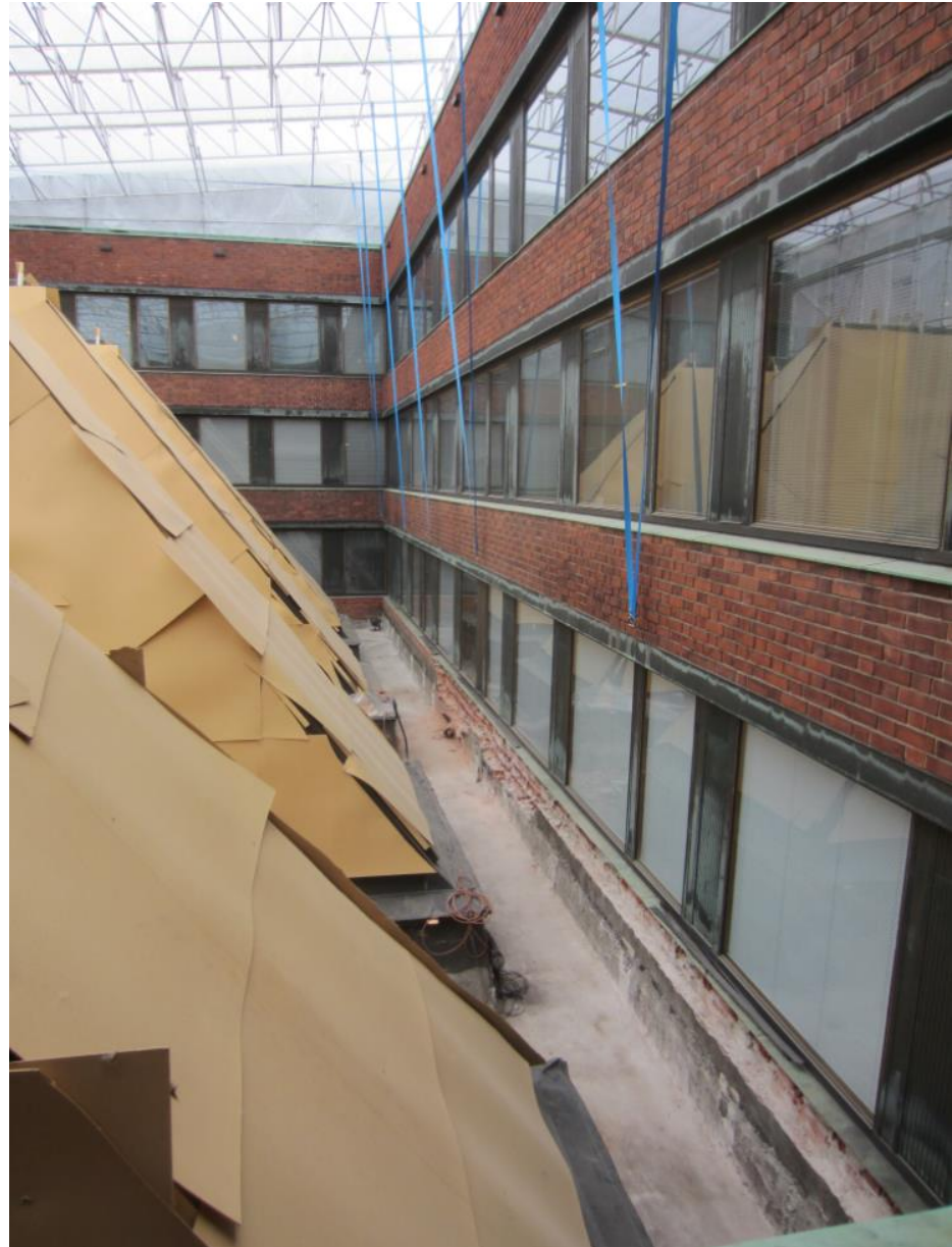
Kattolyhtyjen korjaustyömaa 2015 (AAM / Jonas Malmberg).
