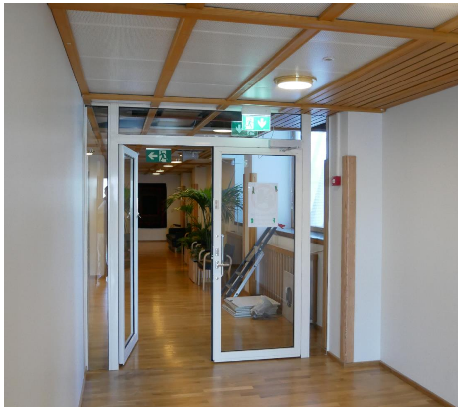
Lisätty kulunvalvontaovi IV-lohkon puoleisessa päädyssä (AAM / Malmberg).
