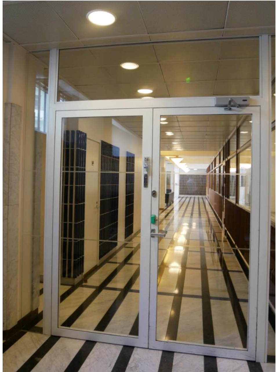
Pääaulasta lähtevän käytävän päädyn kulunvalvontaovi (AAM / Jonas Malmberg).
