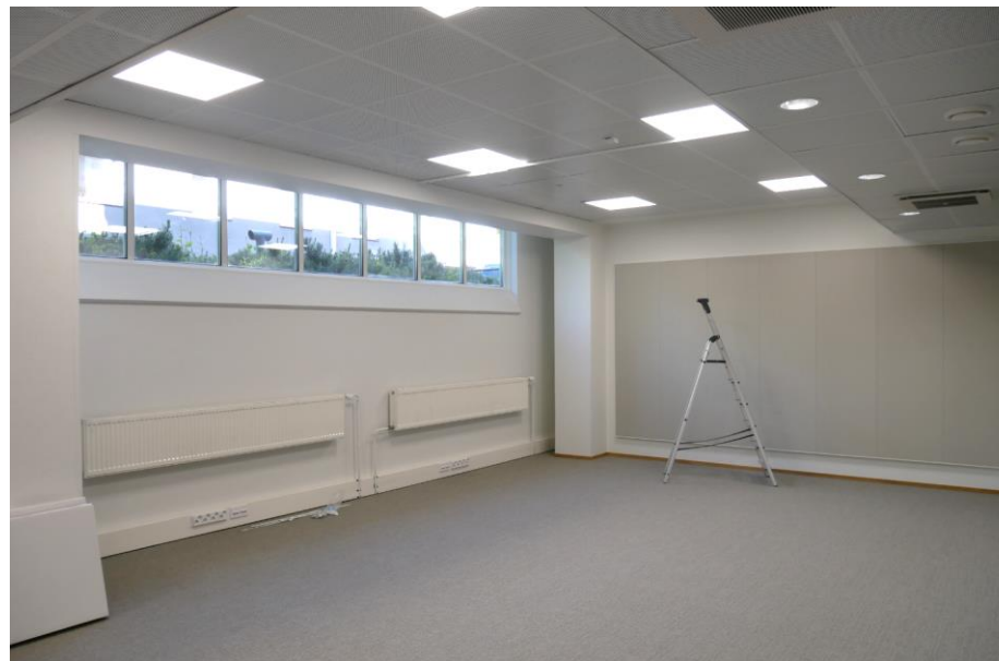
II-lohkon uutta toimistotilaa entisessä postitushuoneessa (AAM / Malmberg).
