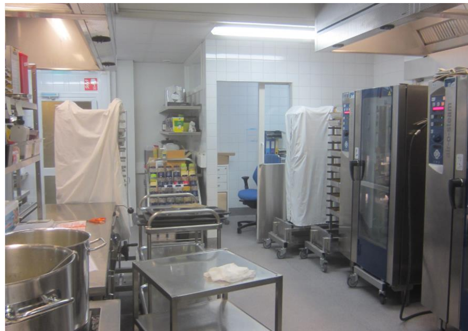
Laitoskeittiön uusittuja tiloja ruokasalin tasolla (AAM / Malmberg).
