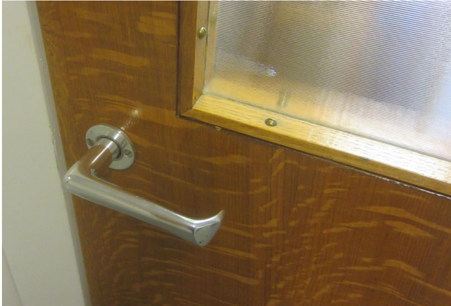
Alkuperäisen mallin mukainen painike ikkunallisessa väliovessa, myös rihlattu lasilienee alkuperäinen (AAM / Malmberg).
