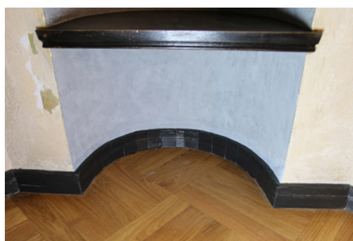
11. Rappauksen kolot täytettyinä ja alue restaurointimaalattuna.
