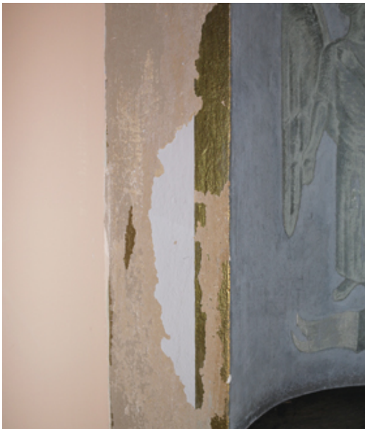
Kuva 16. Smyygien maali irtosi suurimmilta osin hyvin.
