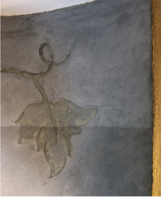
Kuva 6. Ero puhdistamattoman (alla) ja puhdistetun (yllä) pinnan välillä on huomattava.
