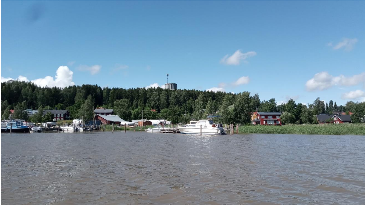
Kuva 7. Paineviemärilinjauksen pohjoispää (Hamarin telakka). Näkymä länteen kohti paineвиemärilinjauksen rantautumisaluetta (kuvan oikea reuna) 8.7.2020. ©Rami Kokko/ARK-sukellus
