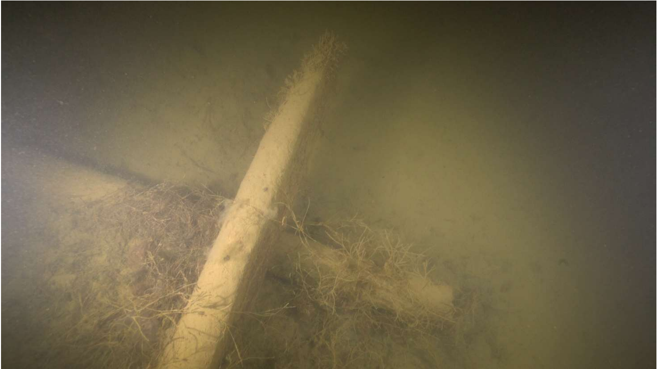
Kuva 9. Viitan keski- tai yläosa, jonka alapäässä on auennut vinoliitos. Kuva. I. Wallin.
