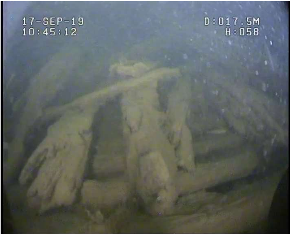
Kuva 25. Perän kuluneita rakenteita.
