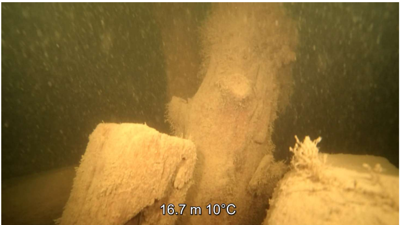
Kuva 14. Peräranka hylyn sisäpuolelta kuvattuna. Rakenneosan kulunaisuuden voi havaita esiin tulleista oksankohdista.
