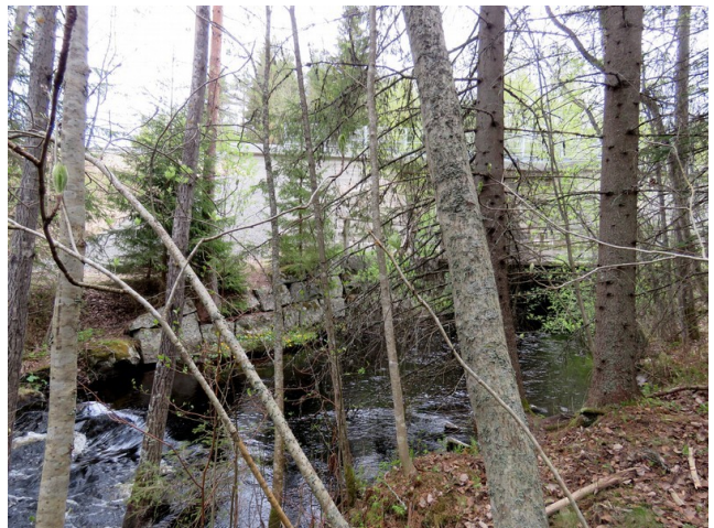
Uittoseinä ratasillan länsipuolella kuvattu koilliseen.
