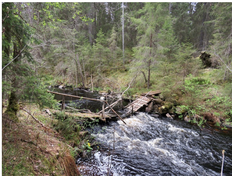
Sortuneen kävelysillan rakenteet kuvattu etelään.
