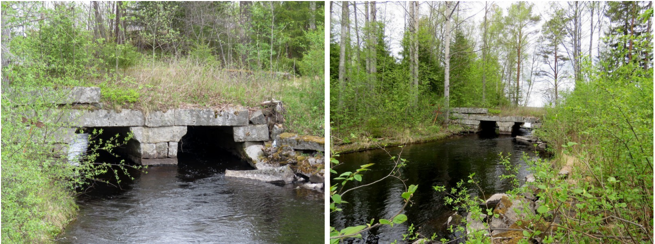
Kohde 1 Ylänivän vanha tiesilta.
