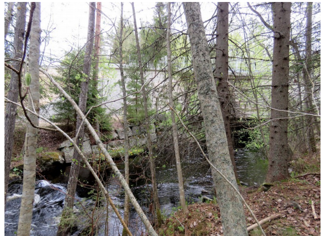
Ratasilta ja ohjauskivikko kuvattu koilliseen.
