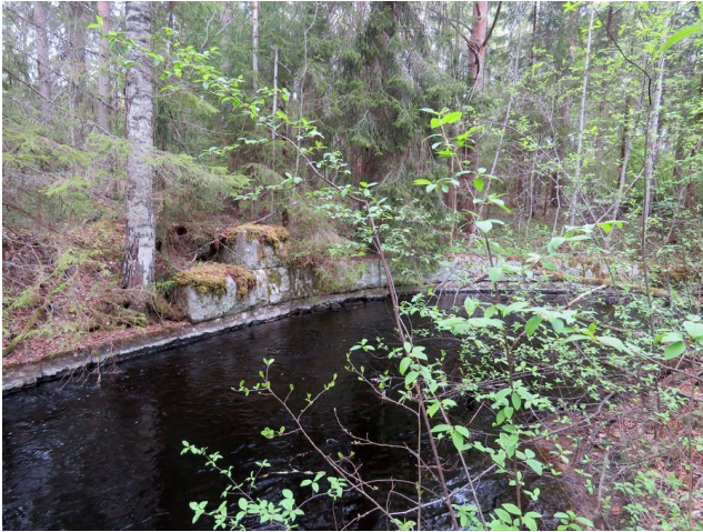
Uittoseinä kuvattu pohjoiseen.
