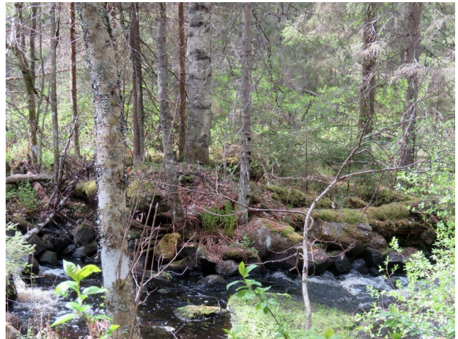
Lohkareista rakennettu seinämä kalliosaaren puolella rännin keskikohdalla.
