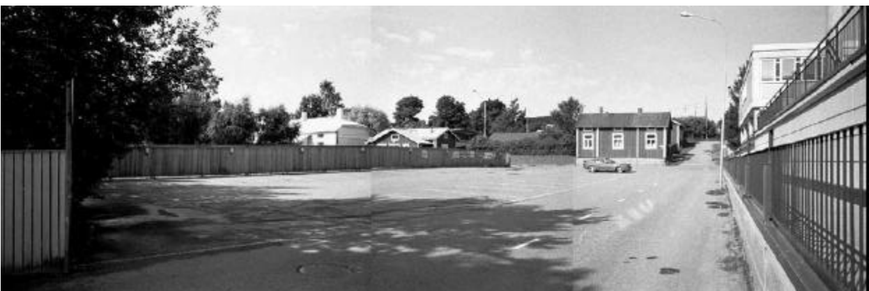
MV/RHOA 125021: 25-27. Panoraama. Poliisitalon eteläpuolella Parmaninkadun ja Aitakadun risteyksessä sijaitsevan tontin 1-132-183 alue on nykyisin tasattu parkkipaikaksi. Alue on tontitettu ja otettu rakennuskäyttöön 1600-luvun lopulla tai 1700-luvun alkupuolella. Tontti on tasattu tuomalla sen eteläreunalle lisää maata. Kuva on otettu Parmaninkadun yli. Kohti SW-W.
