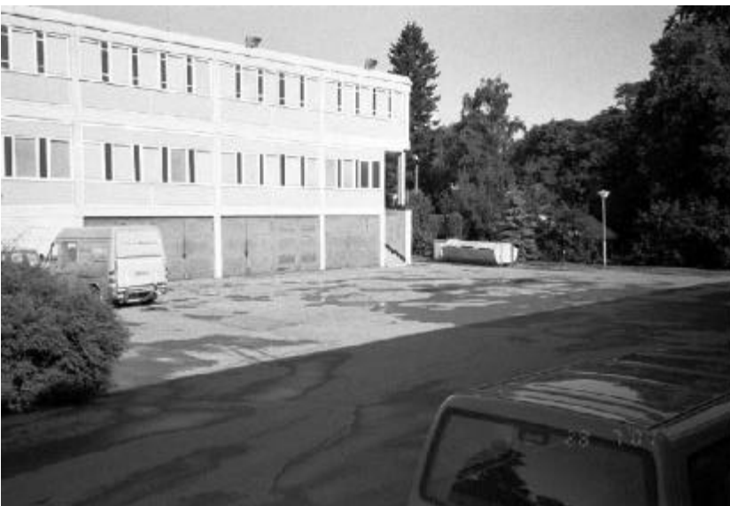
MV/RHOA 125021: 17. Poliisitalon ja postin tontti (2-239-10) on otettu rakennuskäyttöön todennäköisesti jo 1600-luvun puolella, vaikka alueen rakennuskanta on kuvattuna ensimmäisen kerran vasta vuoden 1751 kartassa. Kuvassa näkyvän poliisitalon ja postin välisen piha-alueen kerrostumat saattavat olla säilyneitä. Kohti NW.
