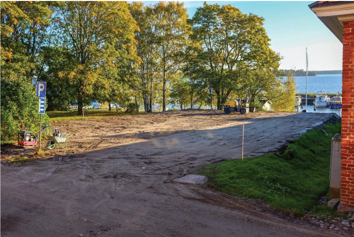
Kuva 10. Pysäköintipaikan laajennus päällystystä vaille valmiina. Kuva lounaasta..(AKDG4631:20)
