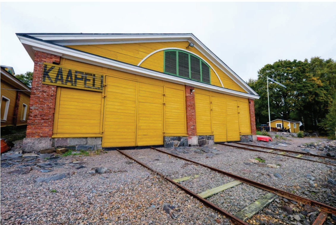
Kuva 2. Venevajan rannan puoleinen pääty. Kuva idästä. (AKDG46931:4)
