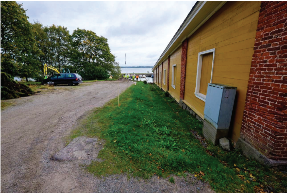
Kuva 3. Nykyinen parkkipaikka venevajan vieressä. Maanpintaa on kohotettu täyttömaalla parkkipaikan kohdalla. Kuva lännestä. (AKDG46931:2)
