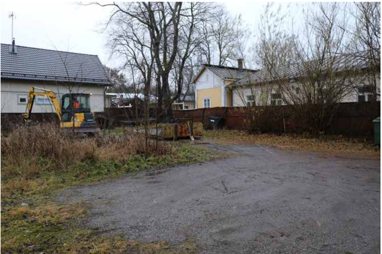
Mutu117038Dg_5. Yleiskuva alueesta 2 ennen kaivamisen aloittamista. Pohjoisesta. 28.11.2017 J. Haarala.
