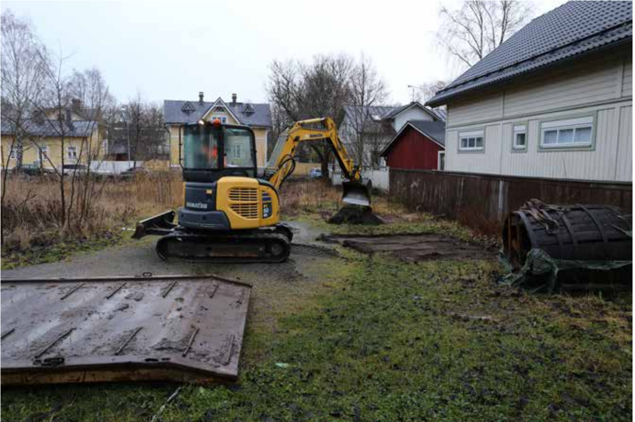
Mutu117038Dg_2. Alue 1:n pintamaa poisto käynnissä. Lounaasta. 28.11.2017 J. Haarala.
