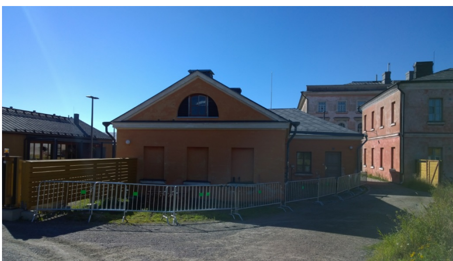
AKDG 5125:3. Rakennus C86 työmaa aidattuna, koillisesta. Kuvaja: Petro Pesonen.
