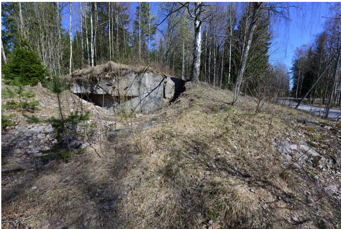
Bunkerbacken 2. Betonibunkkerin ampuma-aukkoa on hieman näkyvissä Sjunbyntieltä päin katsottaessa. Kuva lännestä. (AKDG4184:2)
