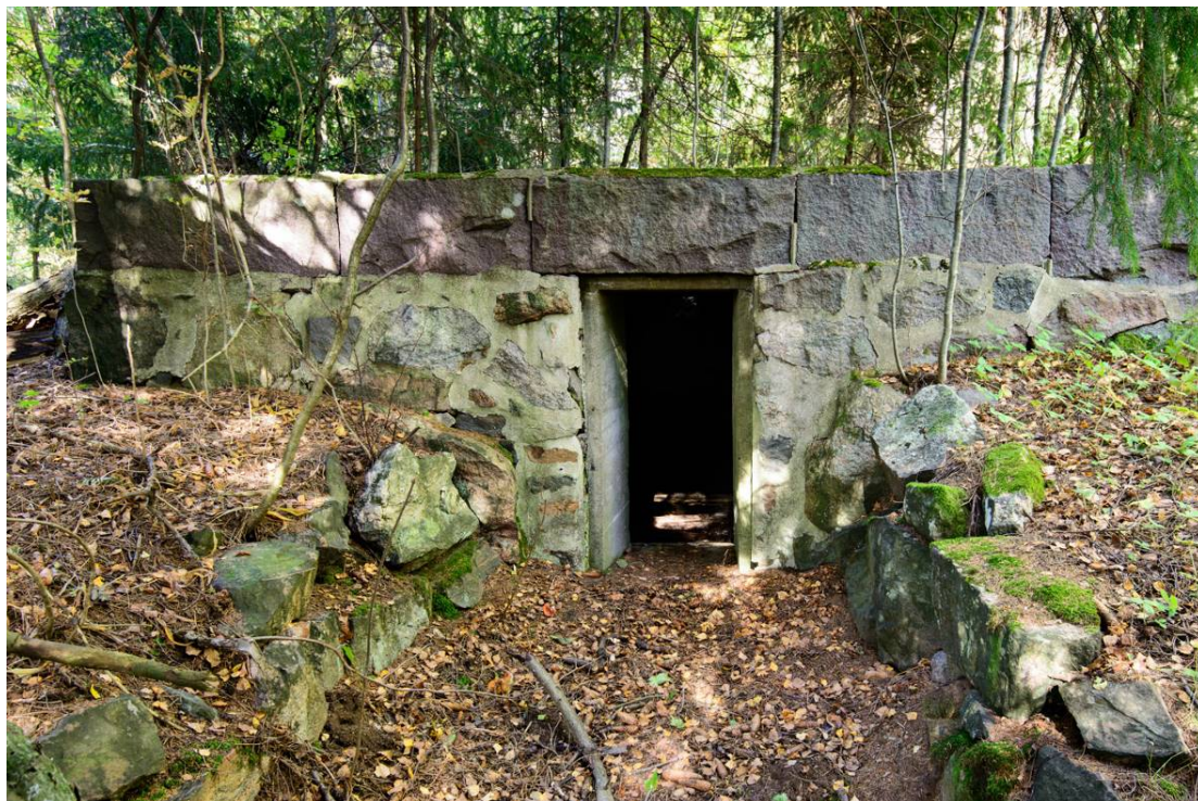
Solbacka. Jyhkeä kellari. Kuva etelästä. (AKDG3981:1)
