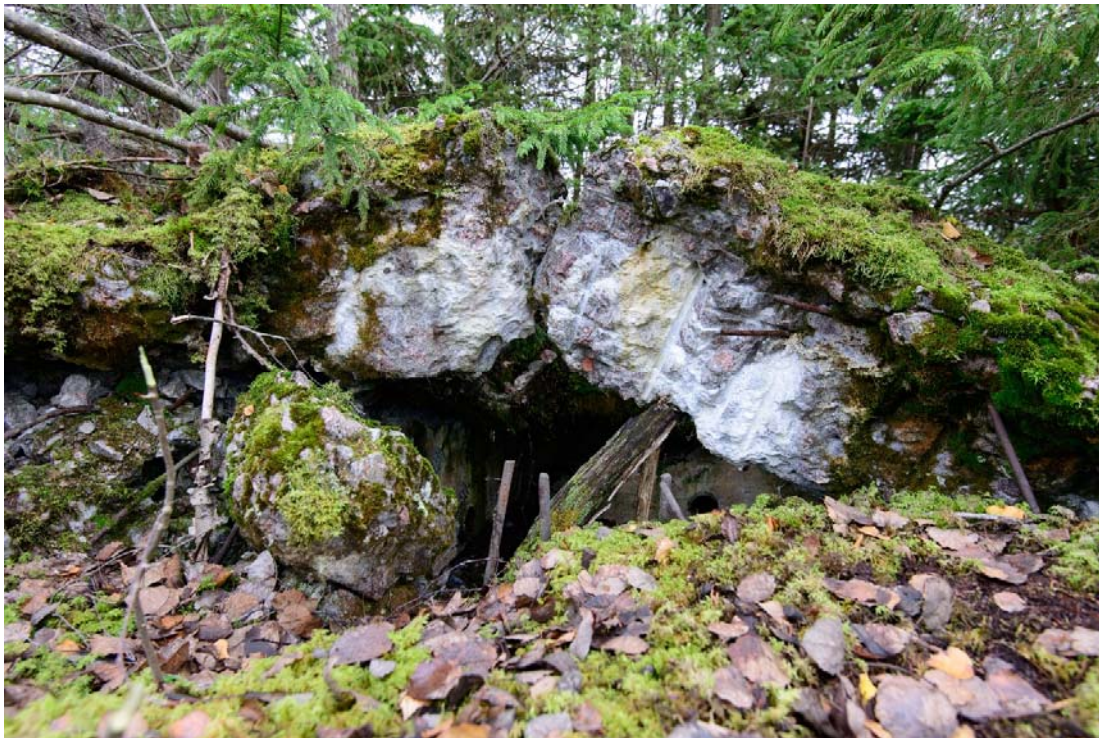
Rödjan 1. Räjätetyn bunkkerin suuaukkoa. Kuva pohjoisesta. (AKDG4188:2)
