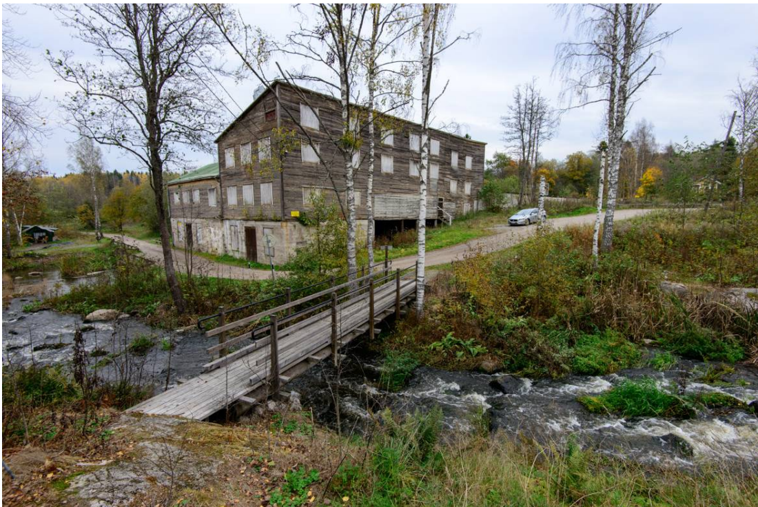
Kvarnby (Kvarnbyfors). Näkymä tien eteläpuolelta muuntajan kohdalta pohjoiseen. Kuvassa 1900-luvun myllyrakennus ja osa koskea. (AKDG4063:2)
