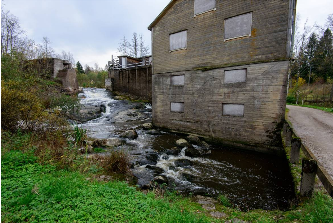
Kvarnby (Kvarnbyfors). Kuva oikeassa reunassa näkyvän illan pohjoispuolelta itään. Kuvassa 1900-luvulla tehty myllyrakennus ja betonista patorakennelmaa. (AKDG4063:1)
