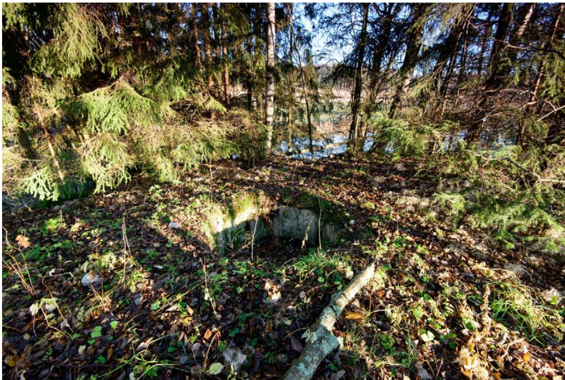
Sjundbyån 2. Bunkkerin tähystyskuvunaukkoa joen rantatörmän tuntumassa. Kuva etelästä. (AKDG4193:1)
