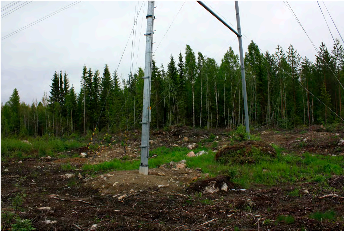
Voimajohtolinjaa, jonka alla pitäisi olla röykkiöitä. Kuvattu etelään. (DG2283:1, kuvaaja Piritta Häkälä)
